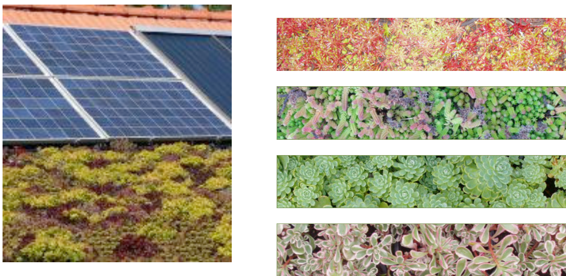
Panneaux photovoltaïques & Toitures végétales
