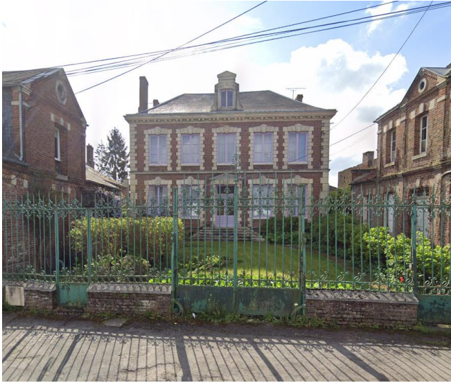
Clôture ajourée posée sur un mur bahut
