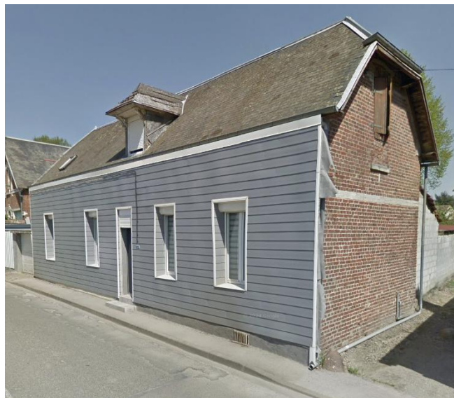
Façade après isolation par l'extérieur
