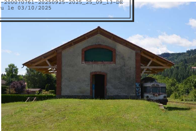
Façade nord de l'ancien bâtiment ferroviaire nommé la Petite Vitesse présent sur le site (photographie prise par Bioinsight).
