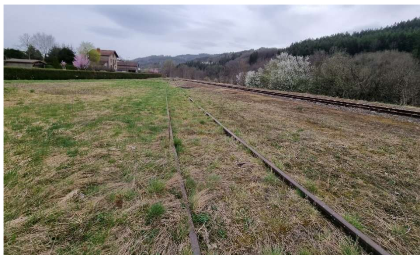
Photographie prise à hauteur du bâtiment ferroviaire de la Petite Vitesse, en direction du sud. On distingue à droite la voie ferrée principale et au centre la voie ferrée qui servait à dévier les trains.
