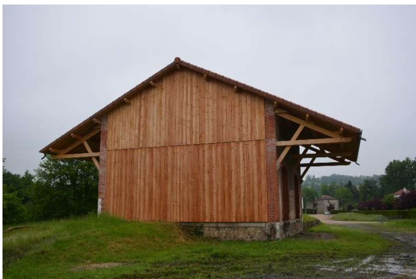
Façade sud de l'ancien bâtiment ferroviaire nommé la Petite Vitesse présent sur le site (photographie prise par Bioinsight).
