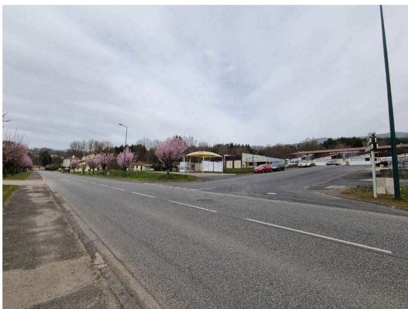
Photographie prise depuis la RD 906 en direction du nord, à hauteur de l'accès à la ZAE du Vernet localisée droite. On distingue notamment le gîte d'entreprises.
