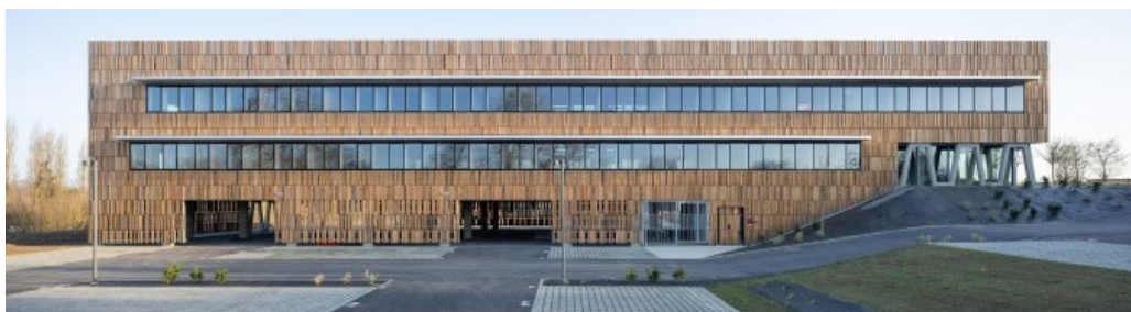
Illustration : bâtiment de l'ANSES – Javené 35 – construction utilisant la topographie du terrain pour l'intégration des aires de stationnement sous les bureaux.
