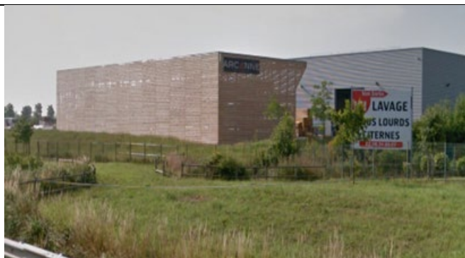
Aire de stockage
