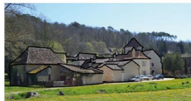
3 Queyssas, densité du hameau vue depuis le fond de vallon «jardiné», vers le versant Est
