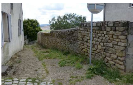
Exemples de murs et ferronneries à conserver
