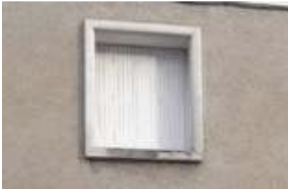
Exemple d'encadrement de fenêtre béton.
