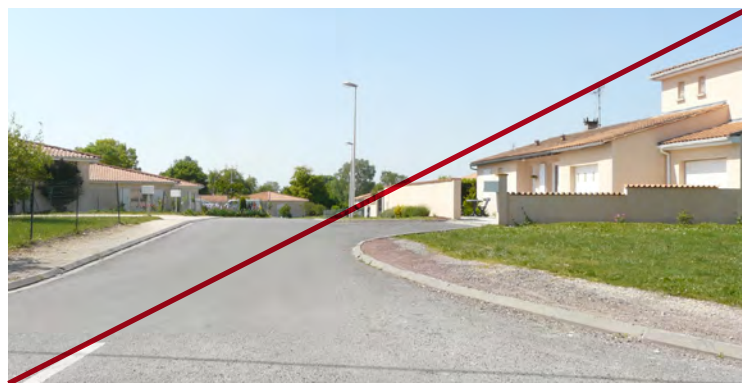
Paysage de lotissement en impasse, déconnecté du bourg, où règne l'enrobé et les bordures béton.
