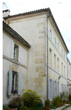
L'enduit devrait affleurer le nu des pierres, sans surépaisseur
