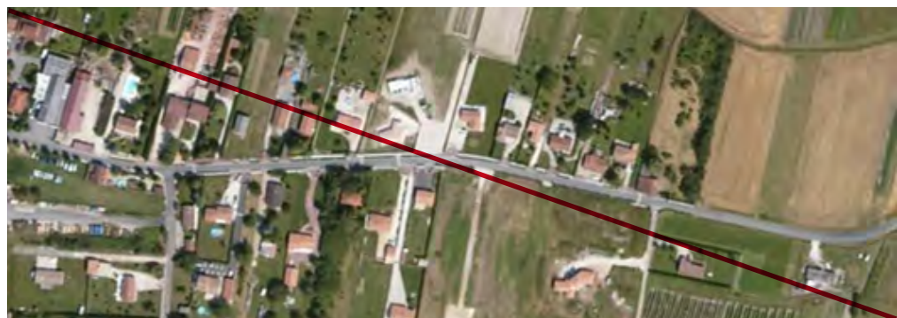
Les extensions linéaires le long des routes nuisent à la qualité des paysages d'entrée de bourgs et créent des couloirs urbains sans intérêt paysager et fonctionnel.
