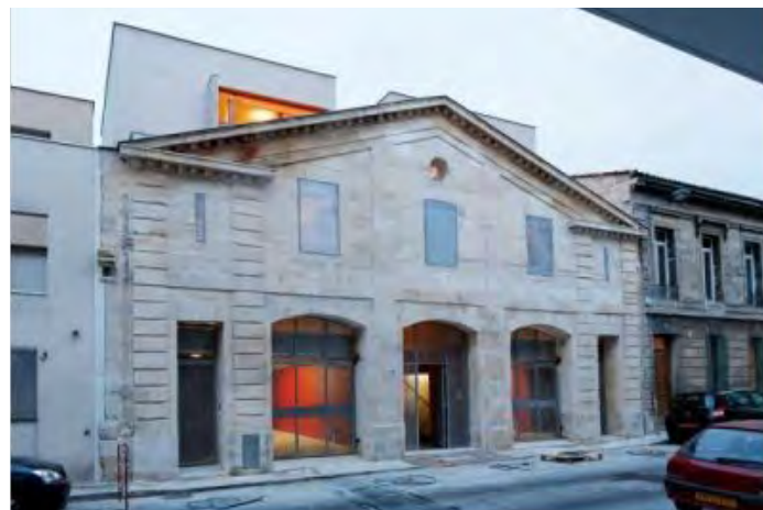
Réhabilitation d'un chais en 20 logements, Bordeaux (33), Architecte Bernard Bühler, 2007
