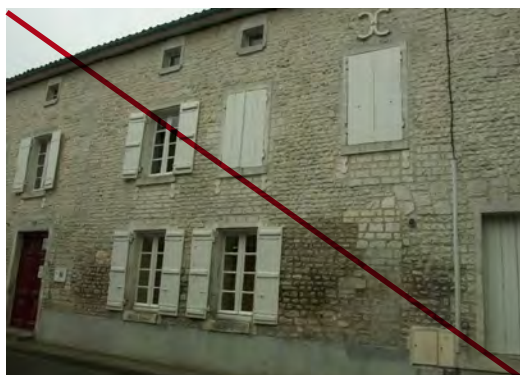
Façade non enduite : seules les structures en pierre de taille devraient rester apparentes
