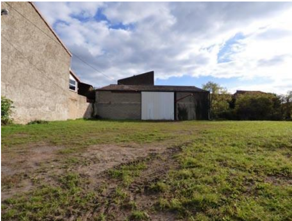
Hangar sur le secteur n°4
