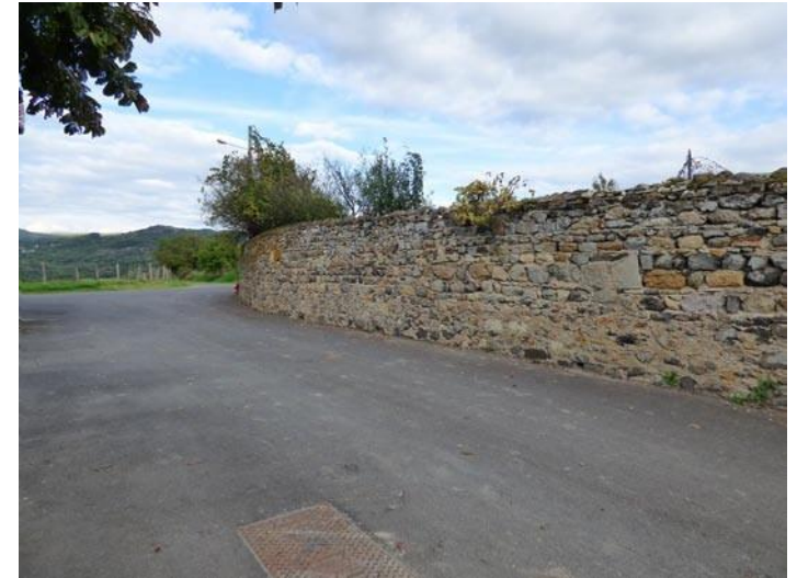
Mur en pierre existant le long de la Rue de la Dinette sur le secteur n°4
