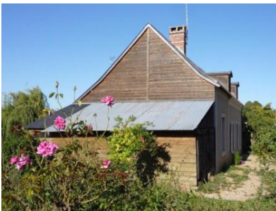
Extension d'une maison traditionnelle - Le Grand-Lucé
