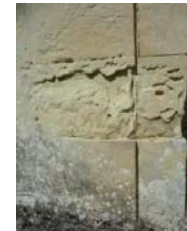
La patine résulte de l'usure naturelle du temps ou d'un réel manque d'entretien.
