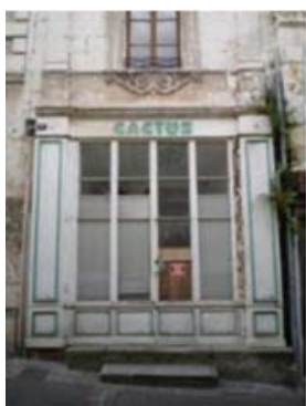
Château-du-Loir – place des Halles
