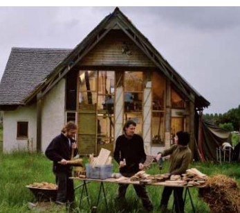
Auto-construction en paille Saint-Germain-d'Arcé
