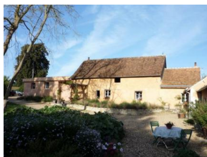
Gîte rural et chambres d'hôtes / extension en bottes de pailles – enduit chaux/sable Savigné-sous-le-Lude
