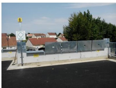
Mise en place d'un dispositif antichute
