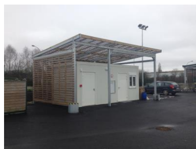
Remplacement du local gardien
