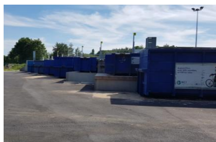
Réhausses des bennes gravats
