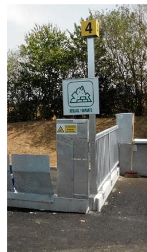
Mise en place d'une nouvelle signalétique
