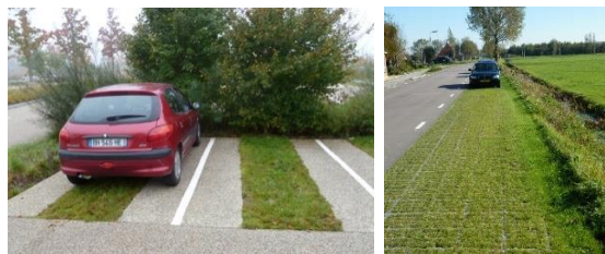
Bandes enherbées et stationnement avec système alvéolaire
