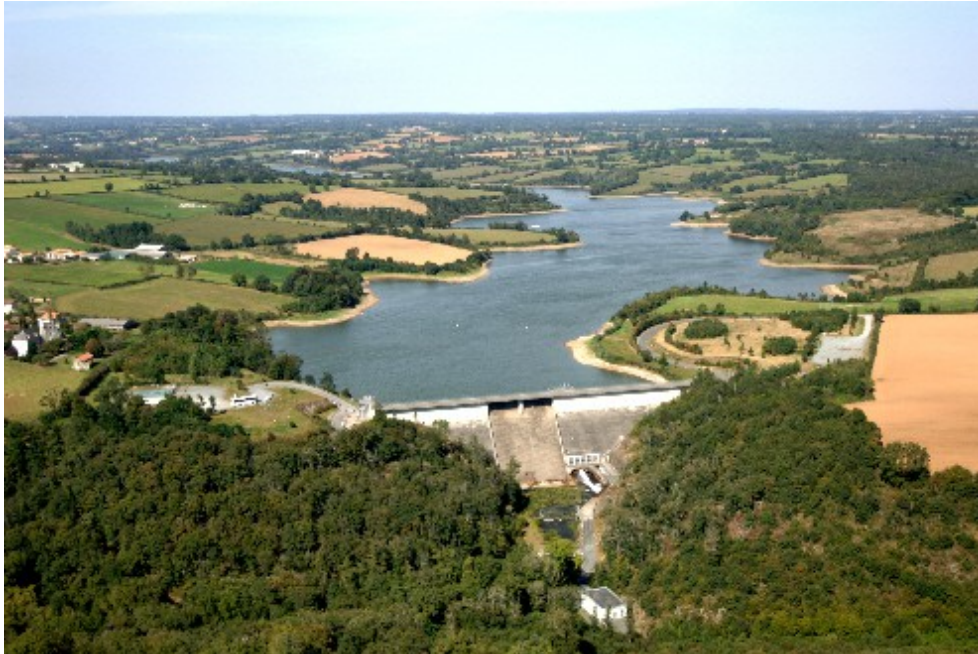
Barrage de la Touche-Poupard
