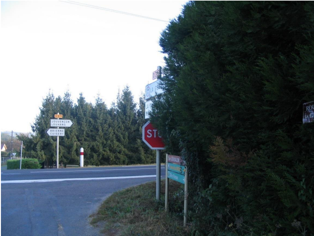
Un défaut d'élégage peut compromettre la sécurité des usagers de la route en cachant les panneaux de signalisation.
