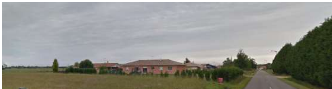
Fig. 3. Photo du secteur 2, en prolongement des constructions existantes
