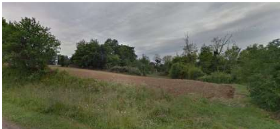
Fig. 8. Photo du site depuis la Route du Moulin (RD405), au droit où le talus est le plus faible
