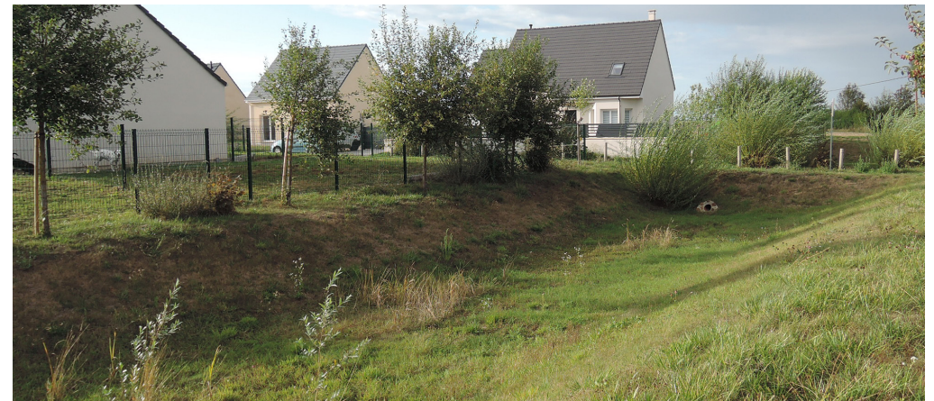
La création d'ouvrages hydrauliques écologiques permet d'améliorer la qualité paysagère et environnementale des projets (exemples illustratifs)
