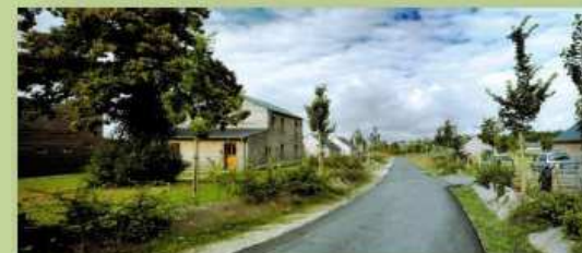
Exemple de traitement sobre d'une voie de desserte de logements, en sens unique (3 mètres de large)
