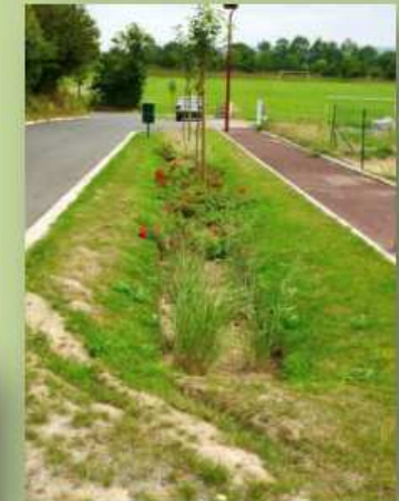
Noues Végétalisées (espaces verts en creux pour collecter les eaux pluviales)
