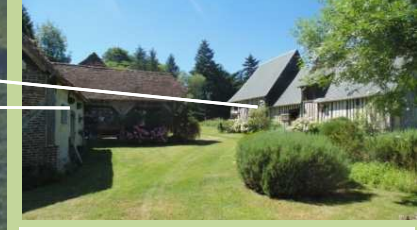
Anciens bâtiments d'exploitation
