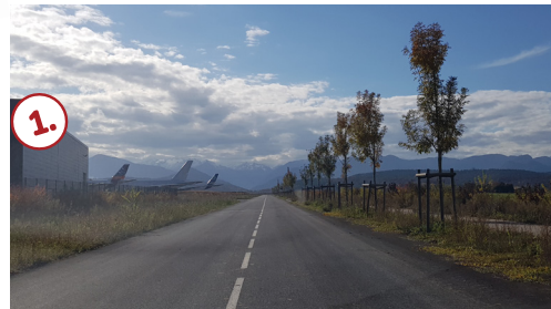
1. Voie existante et aménagée desservant le site de l'entreprise Tarmac, Phase 1.1 de la ZAC Pyrénia
