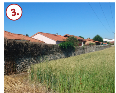
Mur en pierres longeant les habitations au sud
