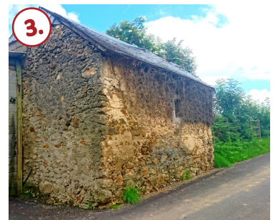
Bâti ancien existant sur le site implanté à l'alignement de la rue Carrère
