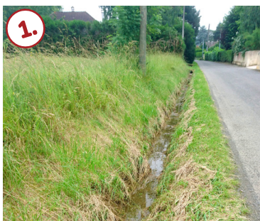
1. Fossé en eau longeant le chemin de Lourdes à prendre en considération
