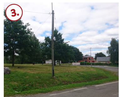
Proximité de la zone bâtie existante en R+1
