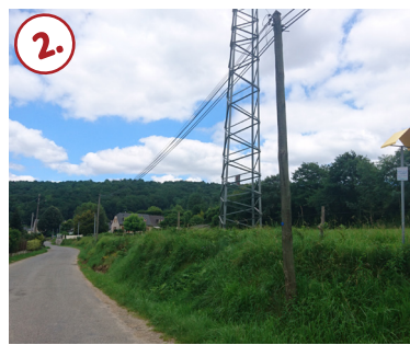
Talus longeant la rue des Pyrénées et pilier à haute-tension
