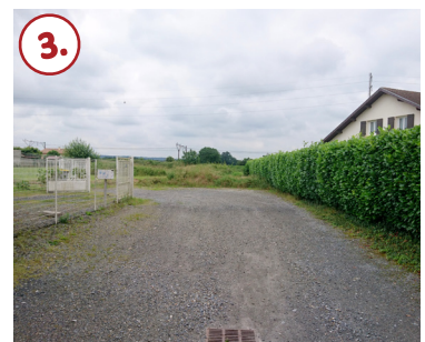
3. Voie d'accès permettant de desservir le site par le chemin de Bastillac à recalibrer
