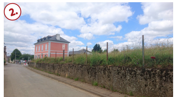
2. Talus et muret séparant le site de la route départementale, rendant l'accès au secteur plus difficile.
