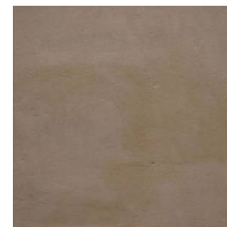
Enduit lissé à la truelle
