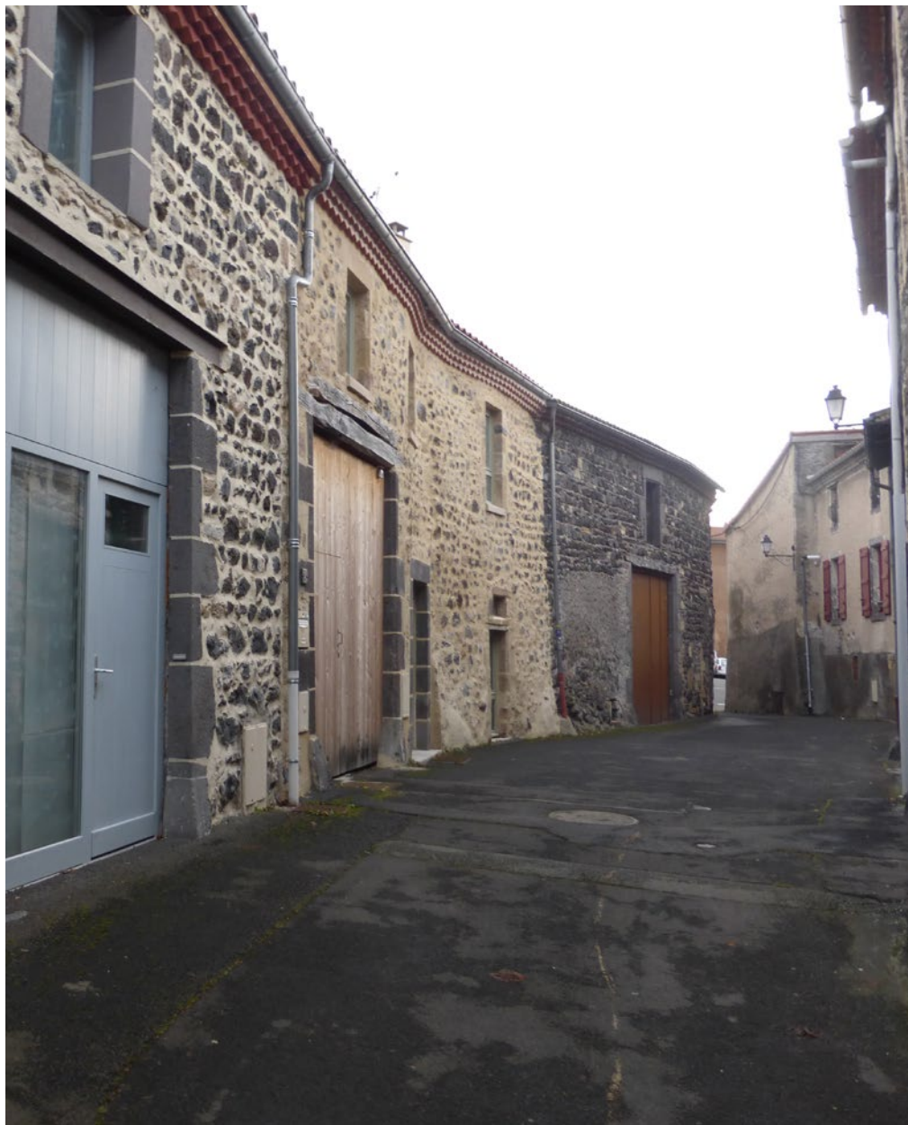
L'air froid circulant entre les interstices des pierres, même des enduits laissant les pierres apparentes ont un impact thermique non négligeable. Les joints doivent être correctement chargés de mortier de chaux.
