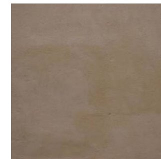
Enduit lissé à la truelle
