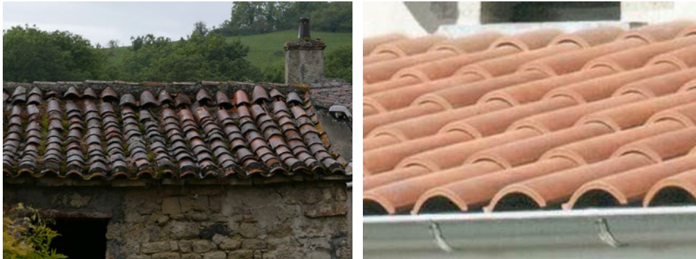
Les tuiles creuses et les tuiles mécaniques à emboîtement grandes ondes sont autorisées sur les constructions neuves et sur les constructions existantes.
