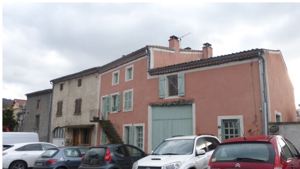
Le bâti caractéristique de la commune est typé : un étage, un galetas éclairé de fenêtres carrés, deux à quatre travées peu ordonnées, une corniche de brique formant génoise, des chambranles marqués.
