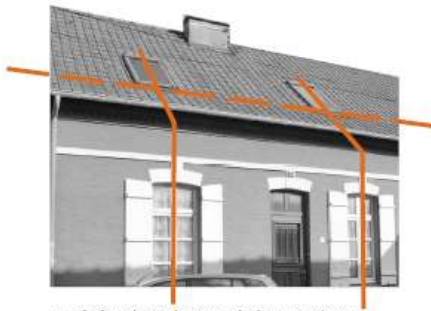
Deux fenêtres de toit identiques, plus hautes que large, et placées dans l'axe des fenêtres.
