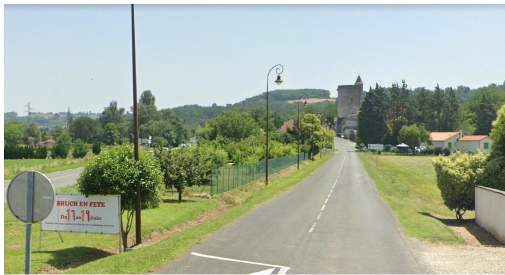
Photo n°1 - Allée du Paravis à sens unique entrant depuis la RD 119
