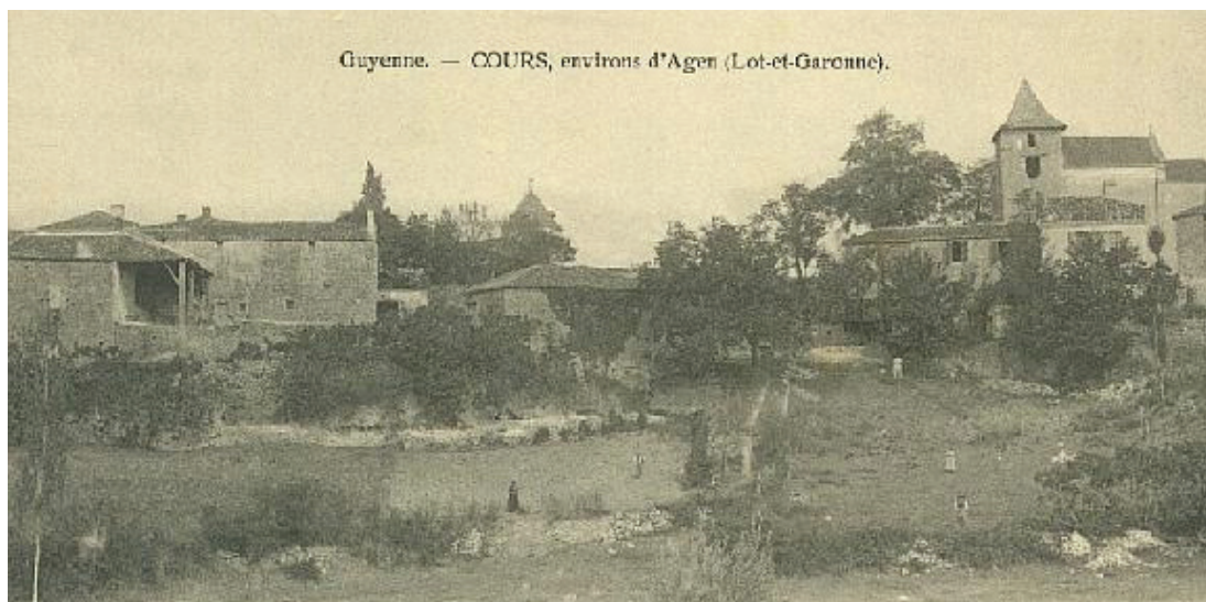
Carte postale ancienne du village, vue depuis Maison neuve (archives départementales)
