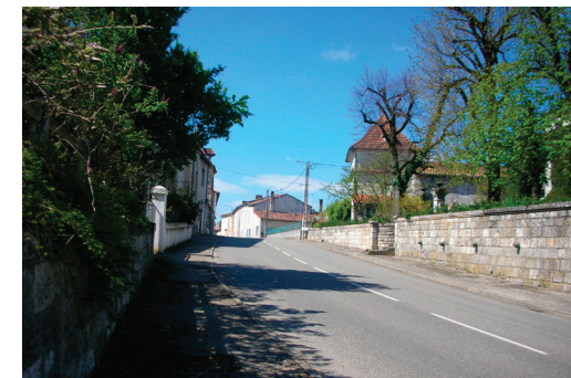
Route départementale traversant le bourg
