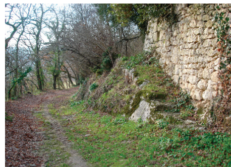
Mur de soutènement/chemin sous Brios
