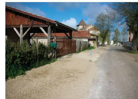
Travaux en cours sur la voie
