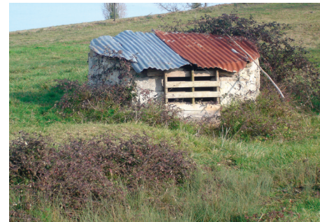
Puits à proximité de Floirac
