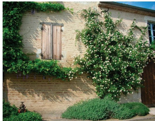
Habitation restaurée au centre du bourg
