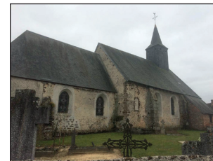
Vue sur le chevet de l'église depuis le chemin de ceinture
