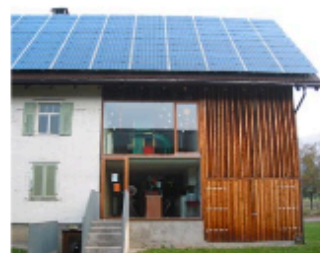
Un ensemble de capteurs recouvre toute la surface du toit, comme une nouvelle couverture. Crèche à Zwischenwasser (Vorarlberg, Autriche) © CAUE 78
