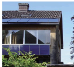
Les capteurs forment un bandeau horizontal qui prend appui sur la ligne d'égout du toit. Maison individuelle (Vorarlberg, Autriche) © CAUE 78
