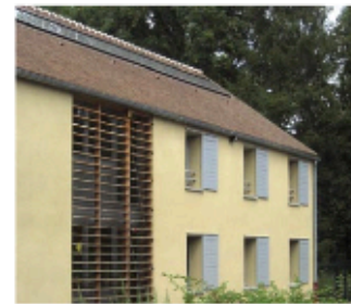
Un ensemble de capteurs thermiques souligne le faitage de la toiture. Centre médicalisé à Bullion (Yvelines). Cabinet Méandre, architectes © PNR Haute Vallée de Chevreuse
