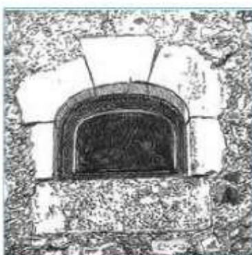
Détail d'une ouverture en pignon
