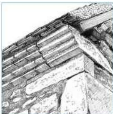
Détail de corniche en brique
