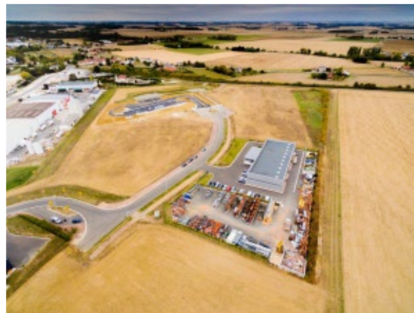
Zone industrielle de Bellegarde – Source : Loire & Orléans Économie
