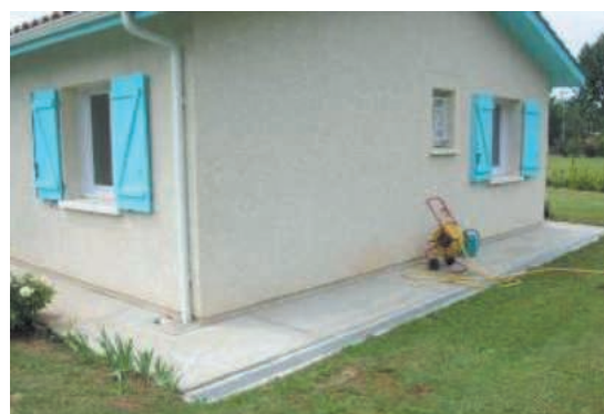
Figure 20 Large trottoir avec caniveau de collecte des eaux de ruissellement (Source Socabat)
