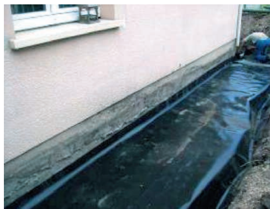
Figure 22 Géomembrane en cours de pose (Source Socabat)
