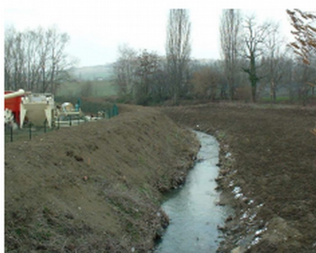
Endiguement en rive gauche du Ranquet (aval R997)
