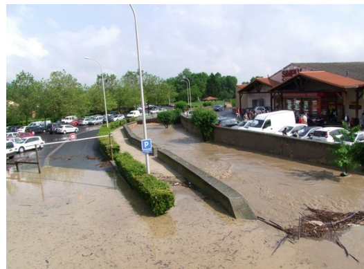
Illustration: Crue de 2012 - Angaud - (centre ville après le passage souterrain de la Poste) – source : Billom Communauté
