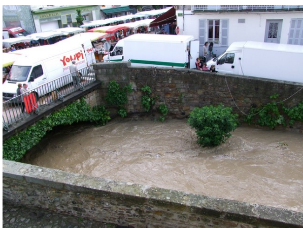
Illustration 8: Crue de 2012 - Angaud (centre ville près du passage souterrain sous la Poste) – source : Billom Communauté
