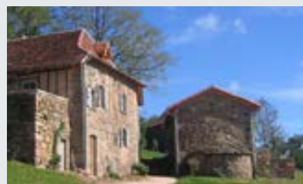
Restauration du fournil en lauzes de calcaire au Bourg (lieu-dit Malepeyre) © phBa architectes
