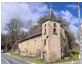
Grange à pigeonnier à Fons
