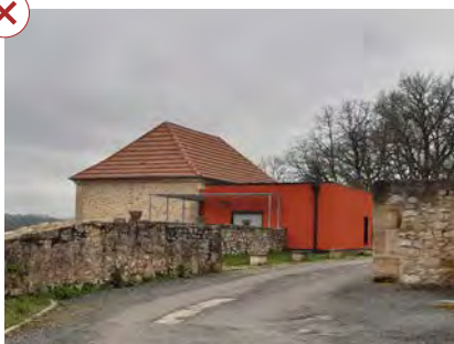
Pas de continuité de matériaux et de couleurs avec l'ancien
