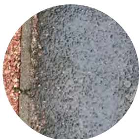
Enrobé à granulats calcaires grenailés
