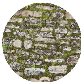
pavés à joints enherbés
