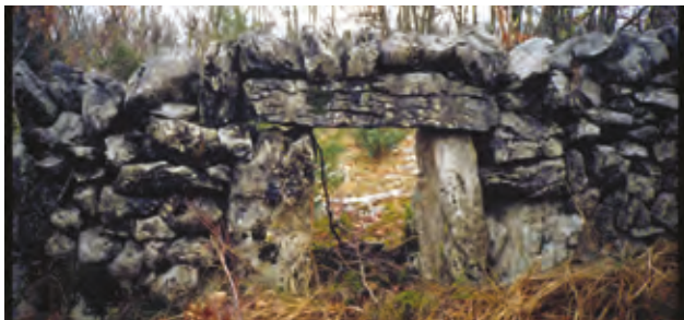
Réalisation de « fenêtres » dans le bas du linéaire des murets en pierre sèche permettant la circulation de la faune.
