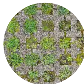
pavés à joints enherbés
