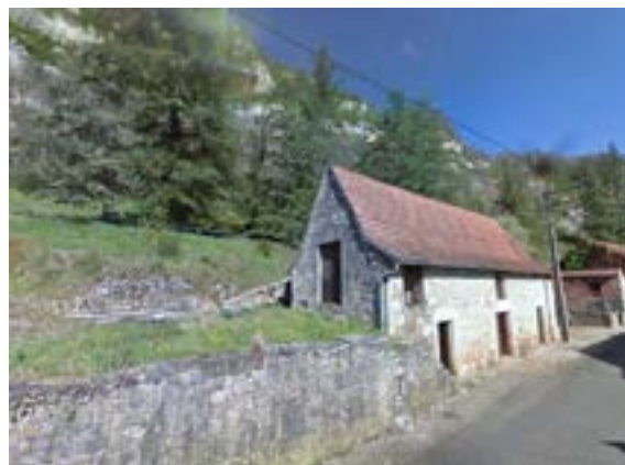
Bâti agricole inscrit parallèlement aux courbes de niveau à Lamagol
