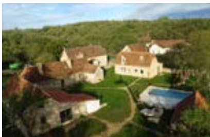
Restauration de la maison de brassiers au Mas de Charles à Livernon © Centre de formation écoconstruction / ETS Vermande
