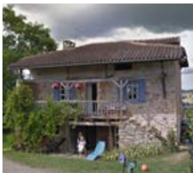
Transformation d'une construction ségalienne en habitation
