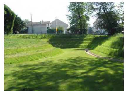
exemple de bassins de rétention
