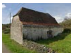
Bâti agricole au bord de la RD71 à Quissac
