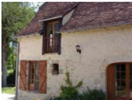
Grange réhabilitée en gîte © La grange quercynoise
