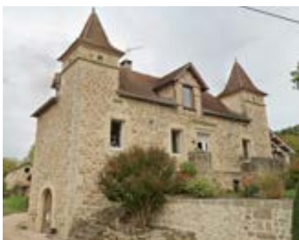
Ancienne maison-bloc réhabilitée à Fourmagnac (Mas des Cazes)
