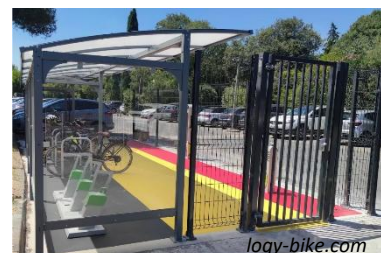
Exemple de parking-vélo en copropriété avec accès particulier, protégé et aménagé
