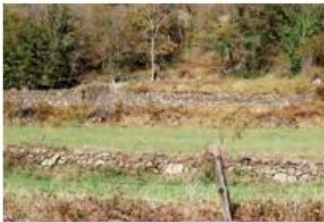
Terrasses et murs de soutènement en pierres sèches qui facilitent le drainage des terrains. Entre Bielle et Bihère, vallée d'Ossau.
