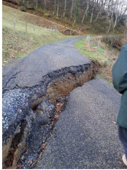
▲ Route d'accès aux Bordes Salanouve et Houndhorbe, février 2014 [17]: affaissement de la chaussée suite à une activation du glissement de cette partie du versant. (Photographies prises par des riverains).
