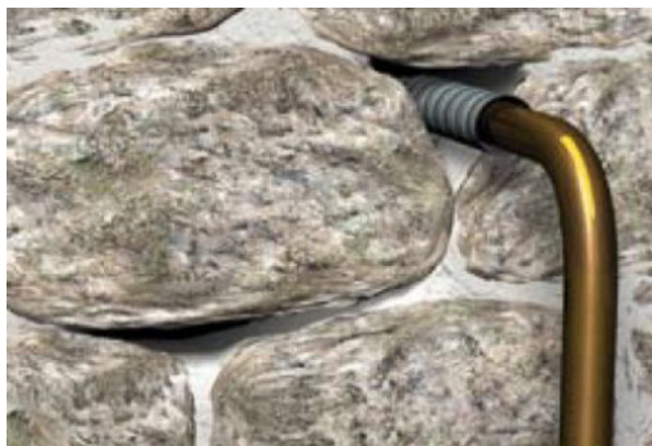
Situation initiale avant colmatage
