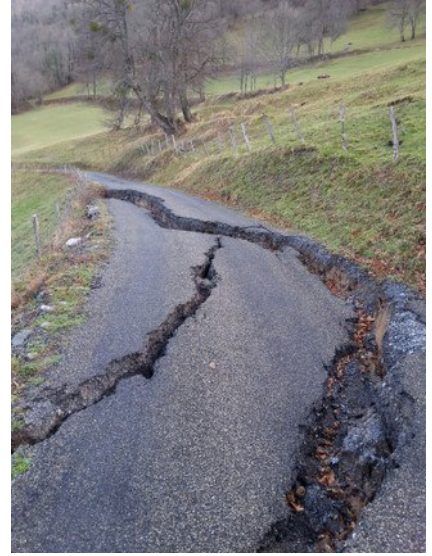
▲ Route d'accès aux Bordes Salanouve et Houndhorbe, février 2014 [17]: affaissement de la chaussée suite à une activation du glissement de cette partie du versant. (Photographies prises par des riverains).
