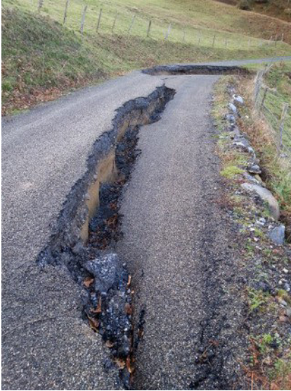
▲ Route d'accès aux Bordes Salanouve et Houndhorbe, février 2014 [17]: affaissement de la chaussée suite à une activation du glissement de cette partie du versant. (Photographies prises par des riverains).
