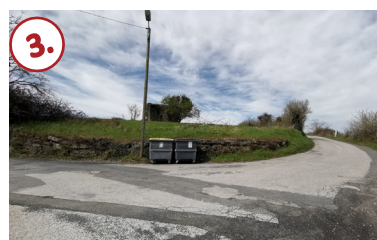
3. Vue depuis le chemin de l'Hermitage avec mur de soutènement apparent.
