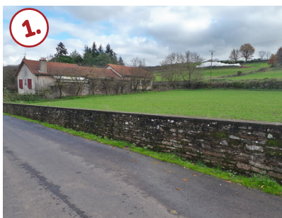
1. L'Est du terrain est délimité par un muret en pierre.
