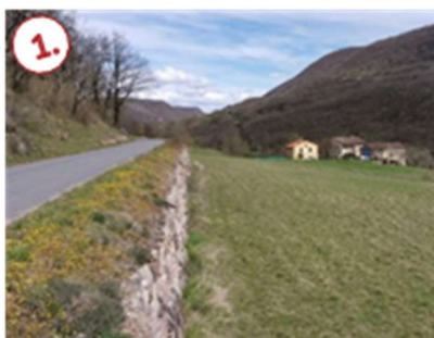
1. Mur de soutènement le long du chemin de Saint-Vincent
