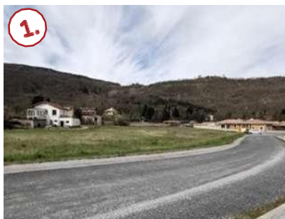
1. Nouvelle voirie du Chemin de la Croix Sainte-Anne desservant le secteur de Couat depuis les nouvelles opérations
