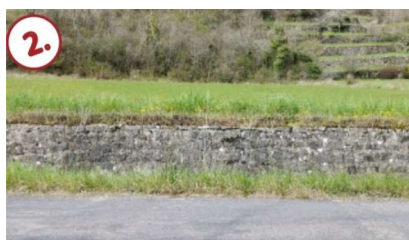
Muret en pierre qui soutient le terrain naturel
