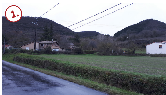
Un fossé et un petit muret en mauvais état longent la parcelle le long de la RD16.
