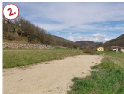
2. Épiérement réalisé au coeur du secteur en vue de l'aménagement d'une future voirie
