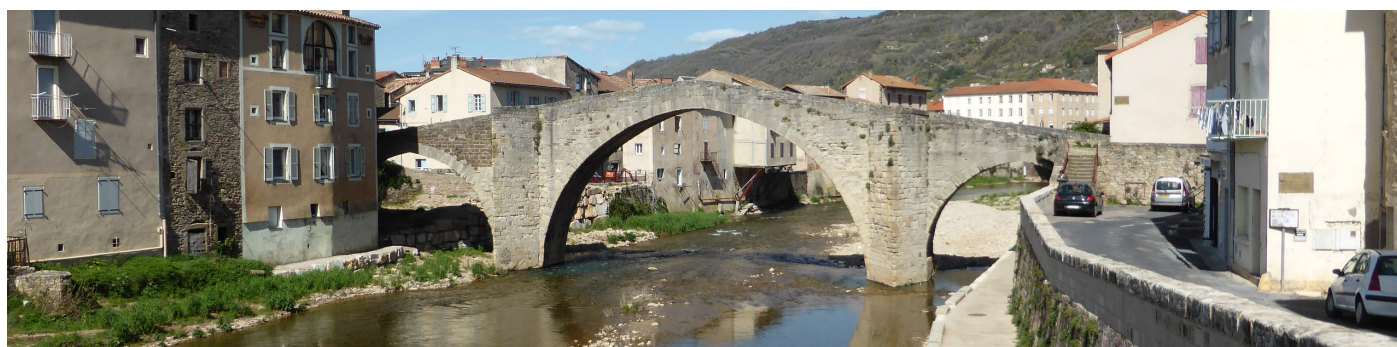
La Sorgue, centre-ville de Saint-Affrique
