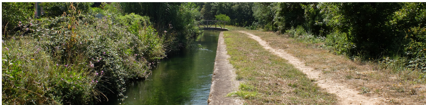
Canal d'alimentation de la centrale hydroélectrique, parallèle à la Sorgue, bourg de Lapeyre sur la commune de Versols-et-Lapeyre
