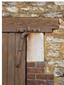
Des détails de portes de granges anciennes sont réutilisables, Nuisement
