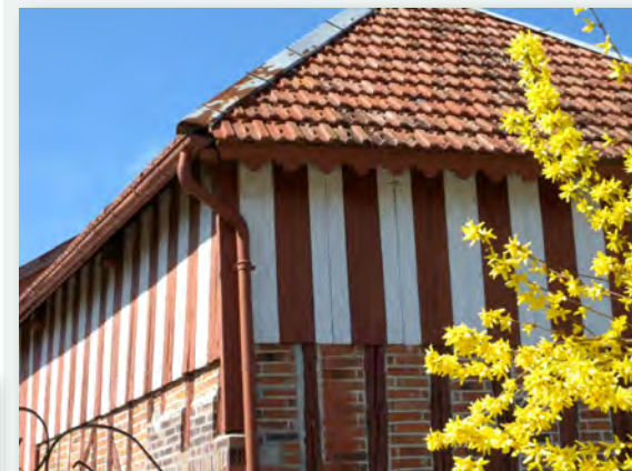
Bardage de planches peintes alternant le rouge et le blanc, s'accordant au pan de bois à remplissage de brique et à la tuile mécanique, Lusigny-sur-Barse
