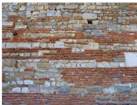
Maçonnerie mixte brique, pierre calcaire, craie, Montiéramey
