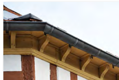
Consoles de bois et moulure de bois peint, Onjon
