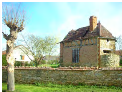
Mur de clôture en calcaire et petite construction à restaurer, Briel-sur-Barse
