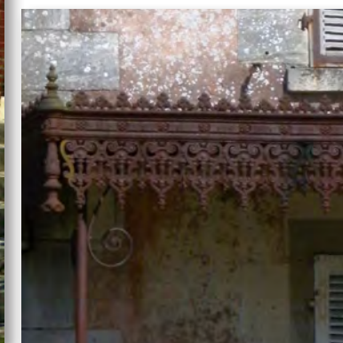
Marquise en fonte avec lambrequins ouvragés, Molins-sur-Aube
