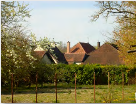
Toitures à deux et quatre pans, tuiles plates anciennes et modernes, tuiles mécaniques, Villemoyenne
