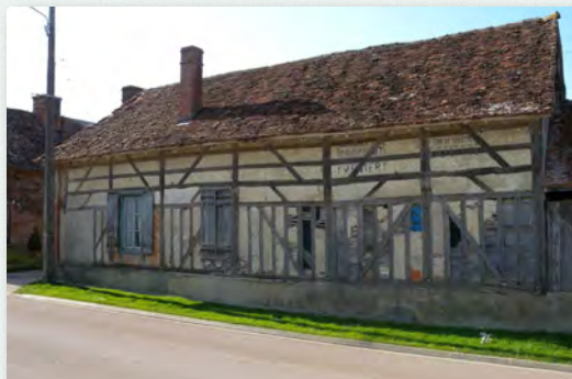
Maison de village en attente d'une restauration, Précy-Notre-Dame
