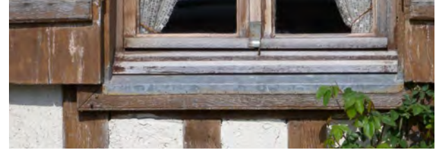
Pièce de zinc protégeant l'appui bois sur pan de bois apparent
