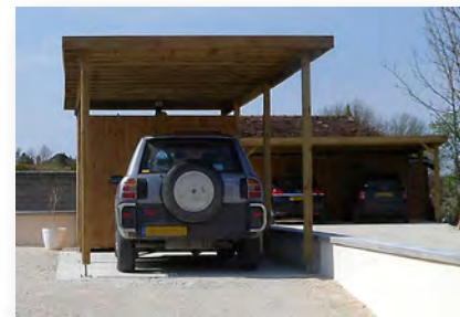
Abri de voiture ou carport, Laubressel
