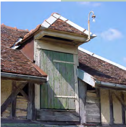
Lucarne porte ou lucarne passante, Mesnil-Sellières
