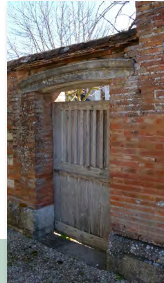
Porte de jardin, mur en brique et en pierre de taille, couronnement de tuiles plates, Montiéramey
