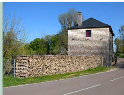
Tas de bois faisant office de clôture, Courteranges
