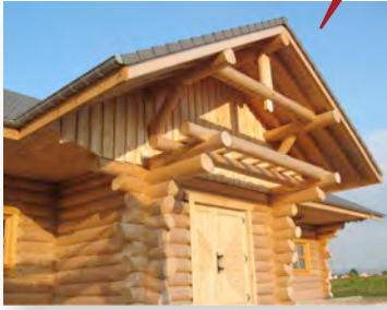
Maison en rondins, technique totalement étrangère à l'architecture du Parc, photo CAD-Construction, Aydat (63)
