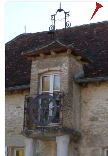
Fenêtre droite dans une baie cintrée
