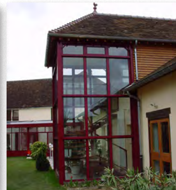
Verrière créée sur escalier en extension du volume bâti, Mesnil-Saint-Père
