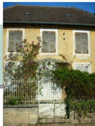
Enduit coloré avec encadrement de fenêtres blanc cassé, Villemoyenne
