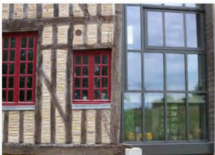
Verrière à structure d'aluminium laqué, transition entre une construction ancienne en pan de bois et une extension contemporaine, Courteranges
