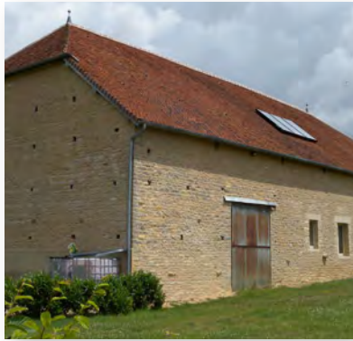
Chauffe-eau solaire, cuve de récupération d'eaux pluviales derrière une haie, Nuisement
