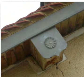
Rive de toit en zinc, protection d'about de panne en zinc avec décor
