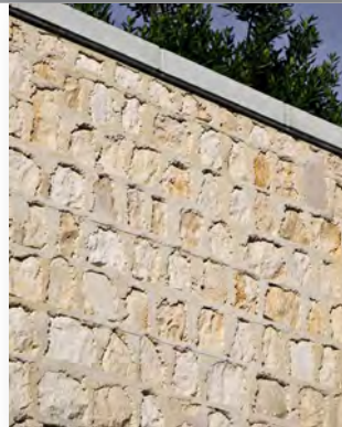
Interprétation contemporaine du mur moellons de pierre calcaire, construction en "pierre banchée" Angoulême (16), A. Chemetoff architecte photo Ph. Peyrefitte arch.
