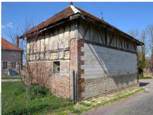
Construction composite : pierre calcaire, craie, brique, pan de bois, apparent à remplissage maçonné enduit, tuile plate, Molins-sur-Aube
