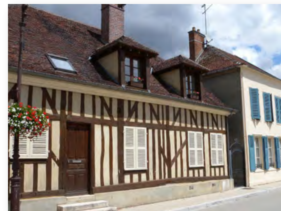
Fenêtre de toit associée à des lucarnes, Brienne-le-Château
