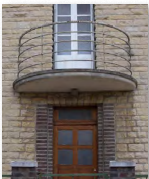
Garde-corps en profils d'acier du commerce, construction des années 1950, Brienne-le-Château
