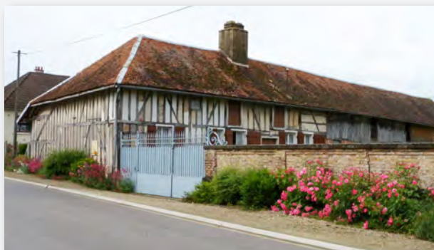
Fleurissement côté rue en pied de clôture de brique et de mur pignon en pan de bois, Rosson
