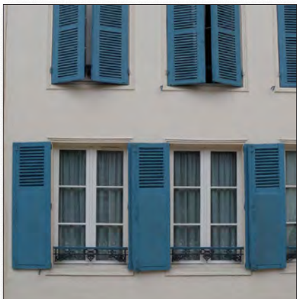
Perçements caractéristiques d'une habitation en ville : fenêtres en bois peint avec petits bois, volets en bois peint, persiennés à l'étage et semi-persiennés au niveau de la rue, garde-corps fonte avec appui bois peint, Brienne-le-Château
