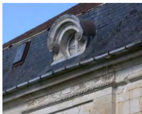
Tuiles plates, gouttière pendante, corniche de pierre à modillons
