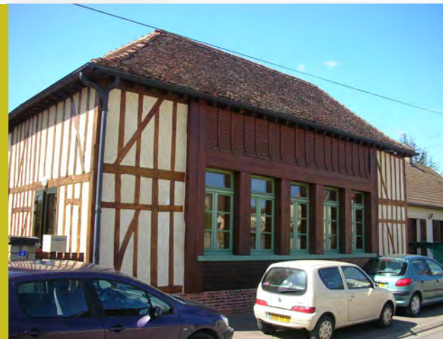
Ancienne grange restaurée avec insertion d'une nouvelle façade vitrée parfaitement intégrée
