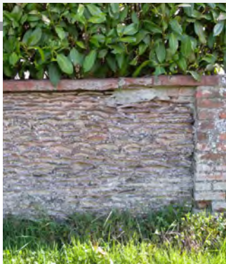
Mur de clôture en maçonnerie de tuiles et de briques, La Villeneuve-au-Chêne
