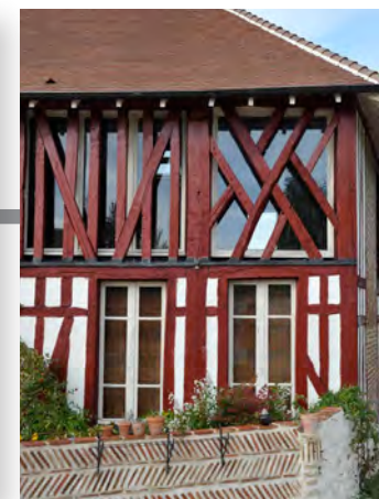
Fenêtres placées derrière le pan de bois
