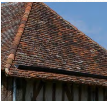
Tuile plate avec gouttière havraise, arrêtier en tuiles rondes
