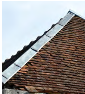
Arrêtier en zinc
