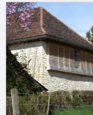
Pierre et tuile plate, association de moellons calcaire et de bardage bois, La Villeneuve-au-Chêne
