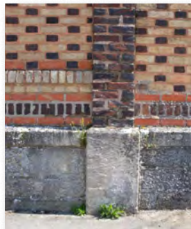
Soubassement de pierre pour un mur en brique polychrome, Lusigny-sur-Barse
