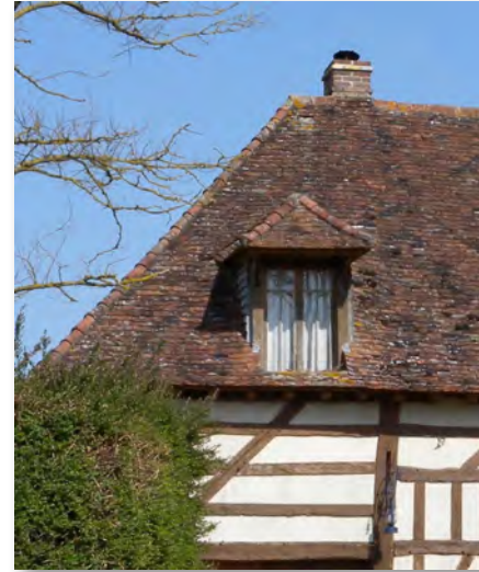
Lucarne de pièce d'habitation, Laubressel
