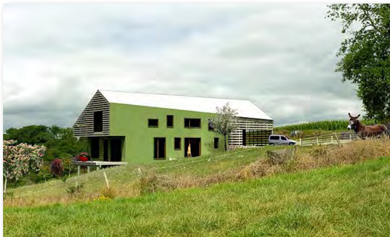
Habitation en techniques mixtes : ossature et bardage bois et maçonnerie revêtue d'un enduit coloré, Cabidos, Pyrénées-Atlantiques, arch. Saillé & Aoustin
