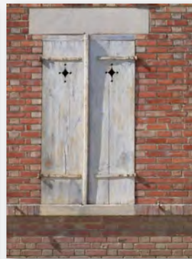
Volet à jour de ventilation, Montiéramey
