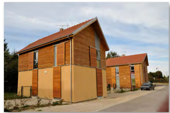
Ossature bois avec béton de chanvre enduit et bardage bois, Mesnil-Saint-Père
