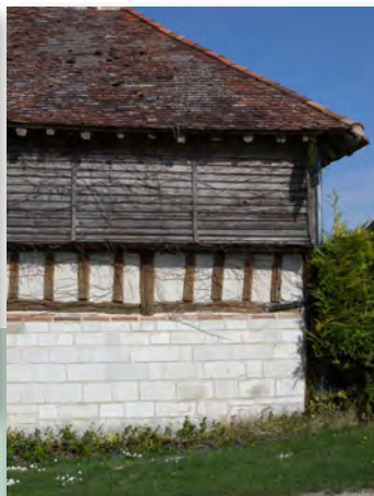
Craie, brique, pan de bois apparent à remplissage maçonné enduit, pan de bois masqué par des clins, tuile plate, Laubressel
