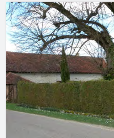
Une haie taillée qui accompagne le portail d'une inflexion, un petit muret de pierre, Lassicourt
