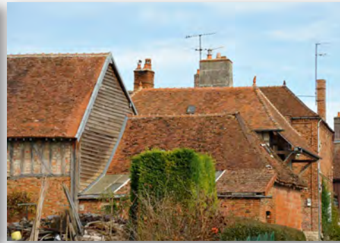
Toitures de tuiles plates, avec croupes côté espace public, Montiéramey
