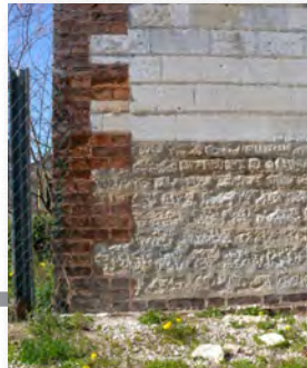
Chaînage de brique pour un mur de moellons calcaire en soubassement et craie appareillée, Molins-sur-Aube
