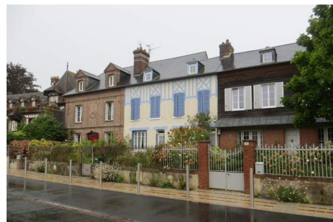
Front bâti en retrait de la voirie existante à Beuzeville
