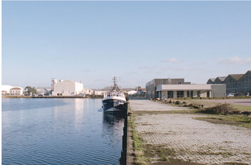
Vue depuis le quai Tostain au bord du bassin Carnot en direction du sud-est
