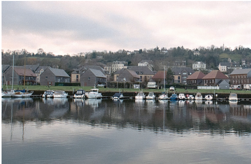
Vue du côté du bassin des chasses en direction du quartier Carnot
