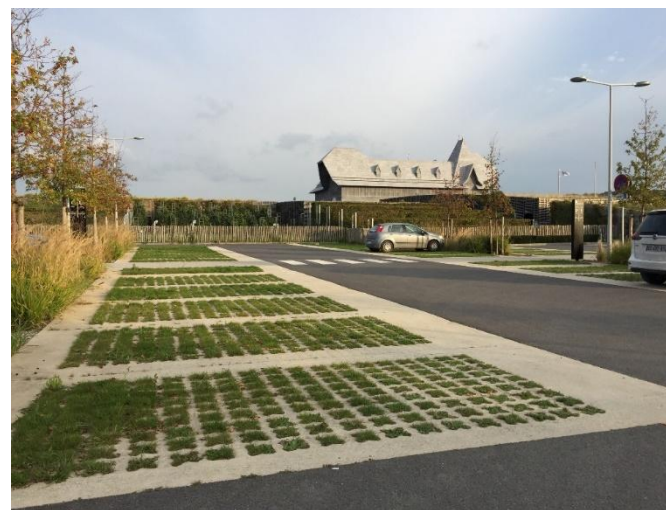
Places de stationnement désimperméabilisées à Honfleur
