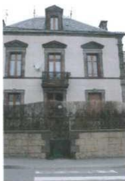
Enduit fin bien réalisé
