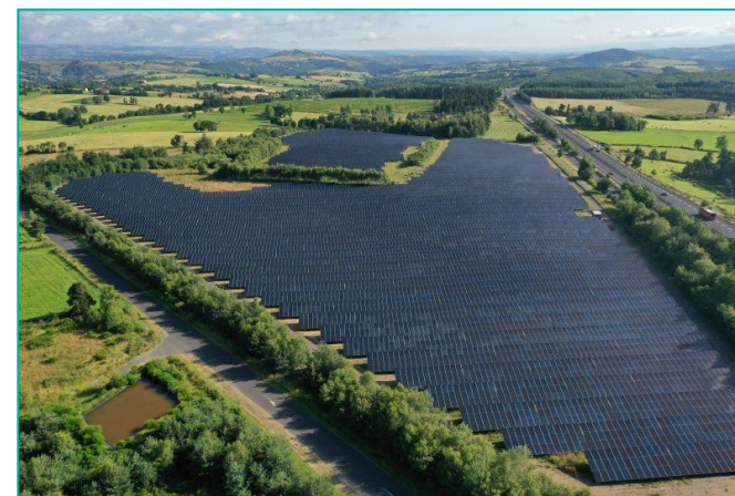
Centrale photovoltaïque de Saint-Mary-le-Plain © Hautes Terres Communauté
