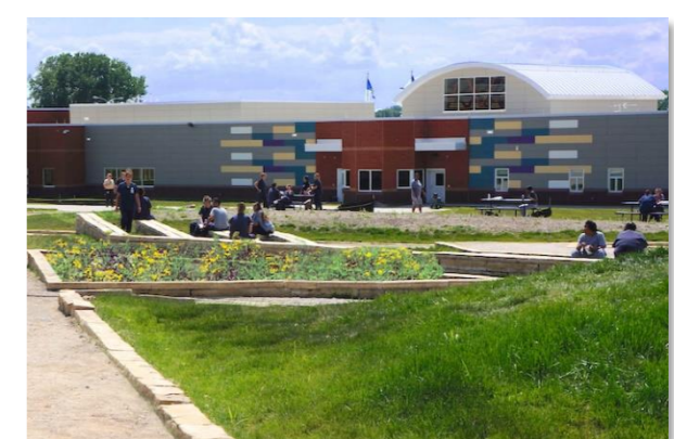
Aménagement public urbain en terrasse
