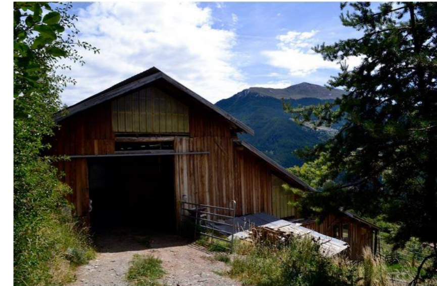
Bâtiment d'élevage dans le Queyras (05) implanté dans la pente. Source : Claire Masquelier
