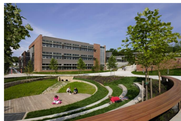
Aménagement public urbain en terrasse
