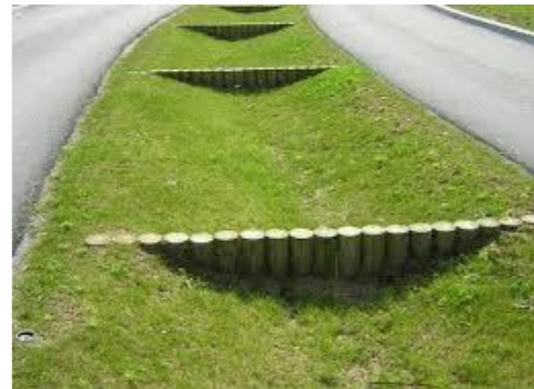
Noue rurale entre voie en pente
