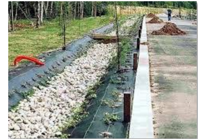
Noue plantée et filtrantes (sols imperméables)
