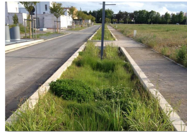
Noue urbaine à plantes semi-aquatiques
