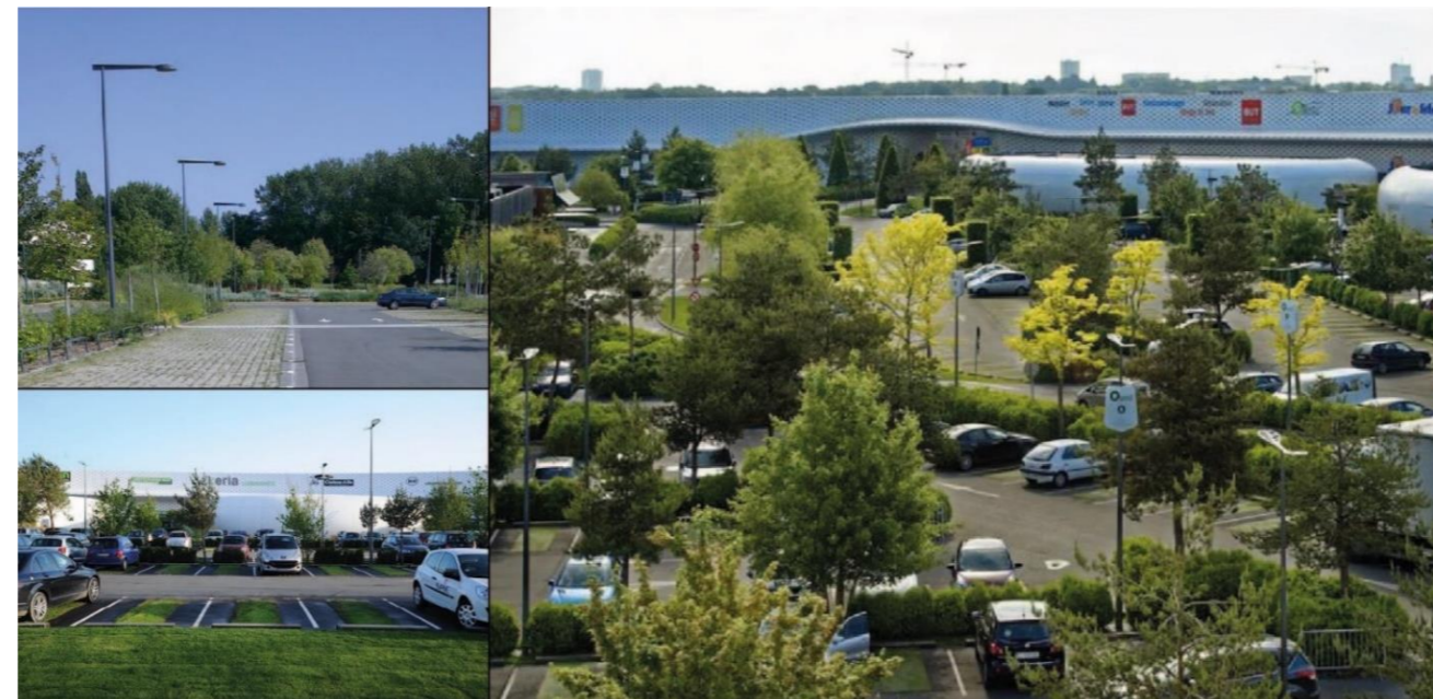
Exemples de parkings paysagers avec places de parking enherbées qui limitent l'imperméabilisation des sols. Sources : Atelier Paul Arène (à droite et en bas à gauche) / Lille Métropole (en haut à gauche)
