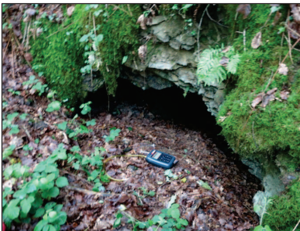
Photo 5 : Montage menant aux dépilages (GEODERIS)
