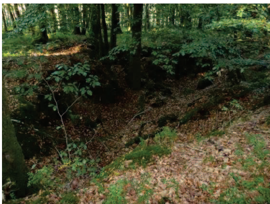
Photo 11 : Fontis travers-bancs N°1 de Doumont
