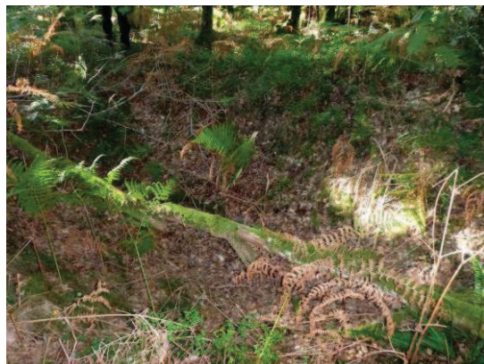
Photo 15 : Fontis Puits de Recherche N°11 de Doumont
