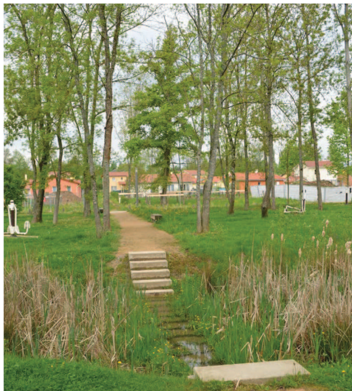
Passage temporairement inondé après un orage, dans l'écoquartier Chambord, Belleville-en-Beaujolais (69) © Cerema
