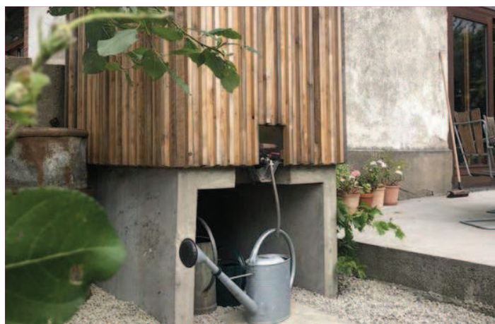
Exemple de stockage d'eau pluviale individuel.
