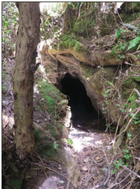
Figure 14 : Entrée du travers-banc Duchesnoy N°4, 2017, Geoderis [89].
