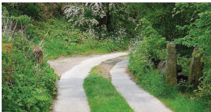
Exemple d'aménagement de chemin rural, carrossable.
