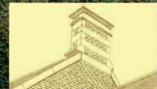
Souche de cheminée en pierre de taille
