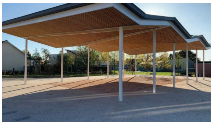
Centre-bourg de Saint-Domineuc (35) : halle couverte qui permet la convivialité et la mixité des usages des espaces publics
