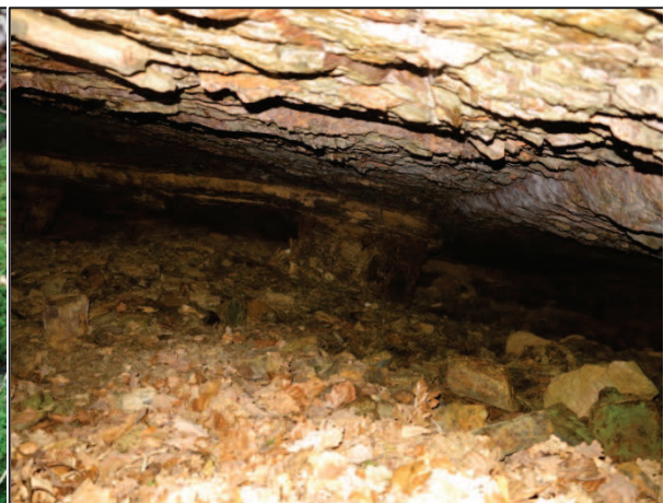
Photo 6 : Intérieur des dépilages (GEODERIS)
