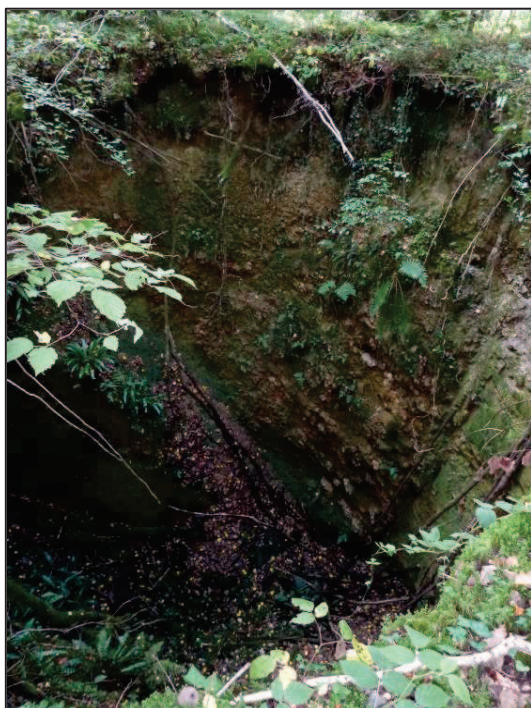
Photo 1 : Fontis Descenderie N°1 de Berdallier
