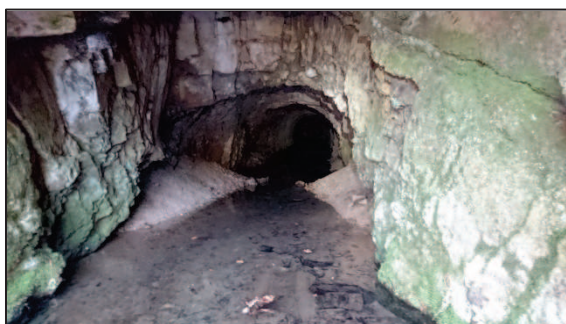
Photo 38 bis : Vue de l'intérieur du travers-banc Est ennoyé
