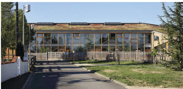
Toiture végétalisée. Ecole l'ISLE D'ESPAGNAC.
