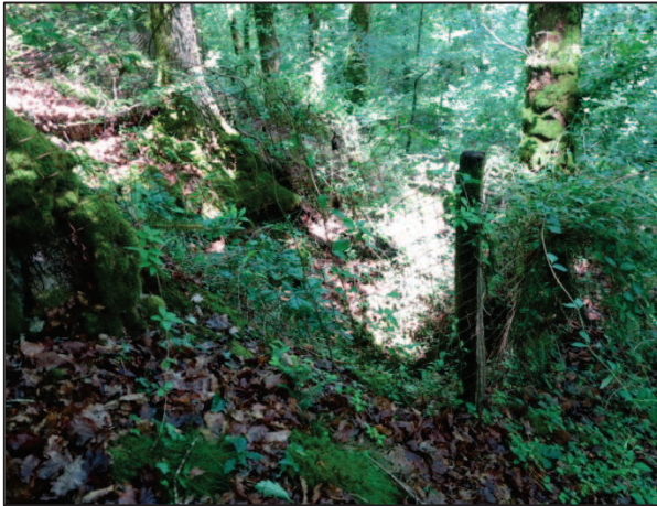
Photo 3 : Tête de la cheminée d'aération (GEODERIS)
