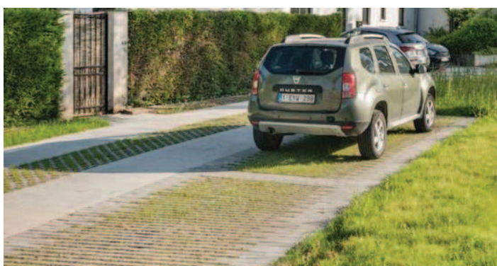
Exemple de voirie semi perméable et végétalisée.
