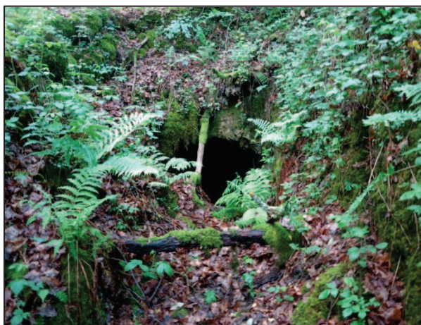
Photo 1 : Entrée du travers-banc (GEODERIS)
