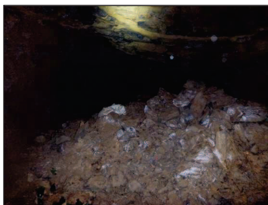
Photo 42 : Remontée de voûte
