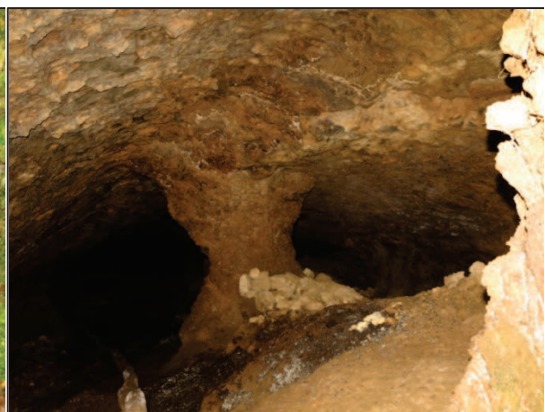
Photo 8 : Intérieur du dépilage (GEODERIS)
