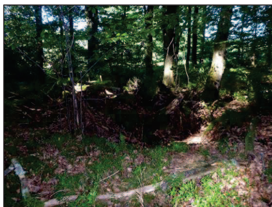
Photo 9 : Fontis Berdallier N°9 remblayé avec des souches
