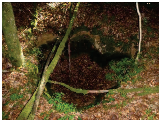
Photo 16 : Fontis Puits de Recherche N°13 de Doumont
