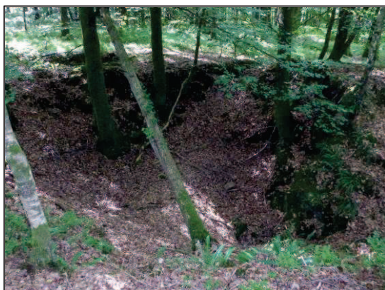
Photo 3 : Fontis Descenderie N°3 de Berdallier
