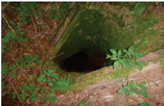
Photo 33 : Cheminée d'aérage N°1 de Bousentier
