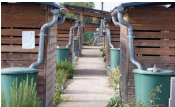
Récupération de l'eau pour les jardins familiaux de l'écoquartier de Saint-Jean-des-Jardins, Chalon-sur-Saône (71) © CAUE 41
