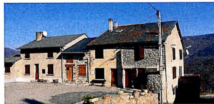
Les maisons des villages de Carcanières, Quérigut, Le Pla, Le Puch et Artigues s'organisent par quartiers. Elles sont en général mitoyennes, en R+1 ou R+1+ combles, de volume simple et intégrant pour certaines un four à pain au premier étage.
