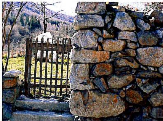
Muret de clôture en pierres sèches
