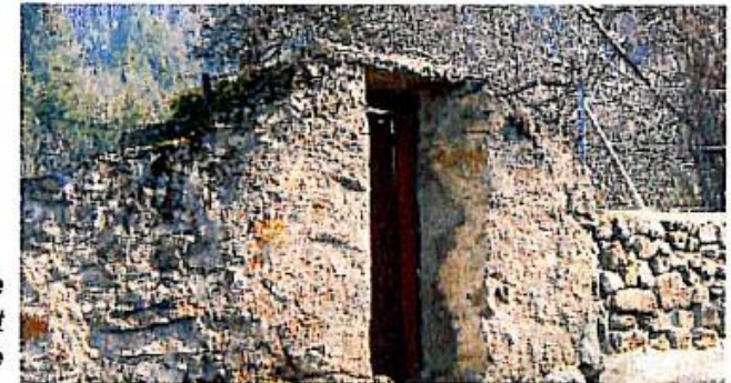
Porte intégrée dans un muret de clôture
