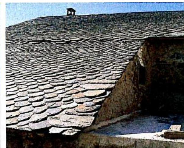
Toiture en lauze à pureau dégressif
