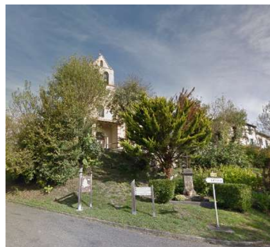
Eglise de Méras, source : Google Street
