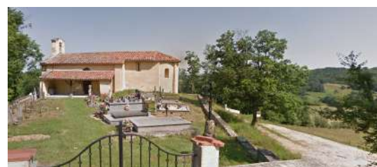
Eglise Saint-Etienne, source : Google Street
