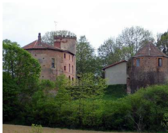
Château de Fornex, source : Autres vues d'Ariège
