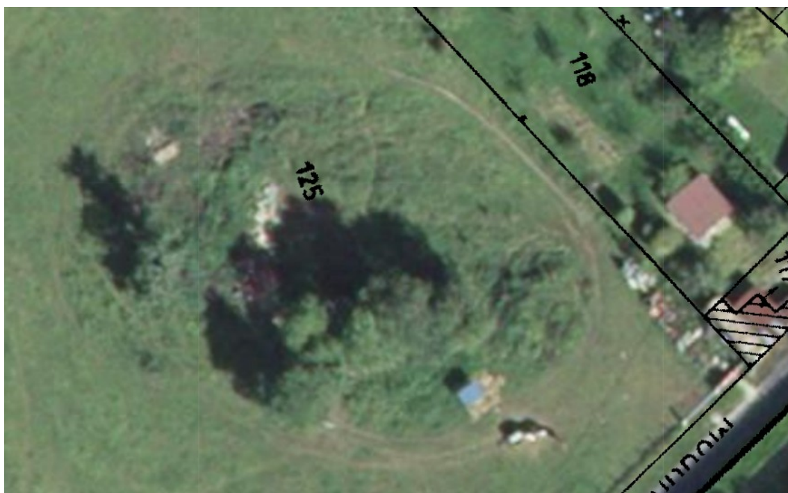
Illustration 11: Vue aérienne de l'effondrement des Auvions, avec la numérotation parcellaire correspondante ©Géoportail-IGN.
