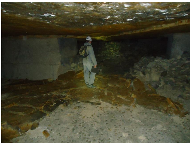
Illustration 19: Exemple de chute de toit dans la carrière. Source : rapport BRGM 2016
