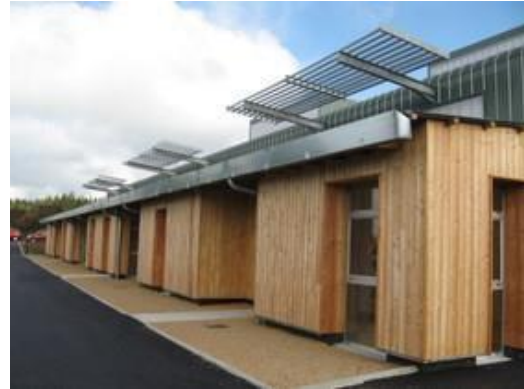
Locaux artisanaux – Saint Julien-Puy-Lavèze (63)
