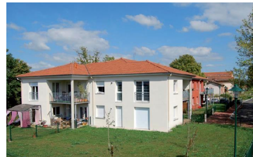
Habitat collectif – Boisset-les-Montrond (42)
