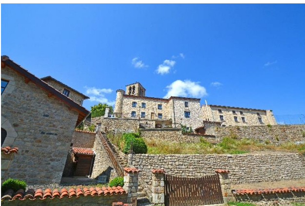
Bâti patrimonial dans le bourg de Roche
