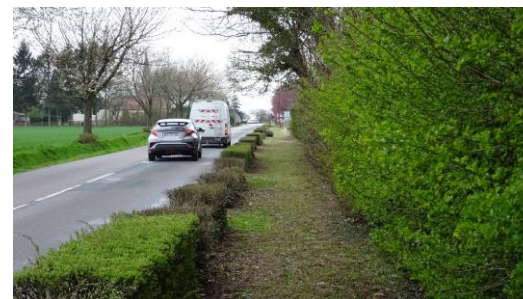
Sente piétonne sécurisée à Fourmetot
