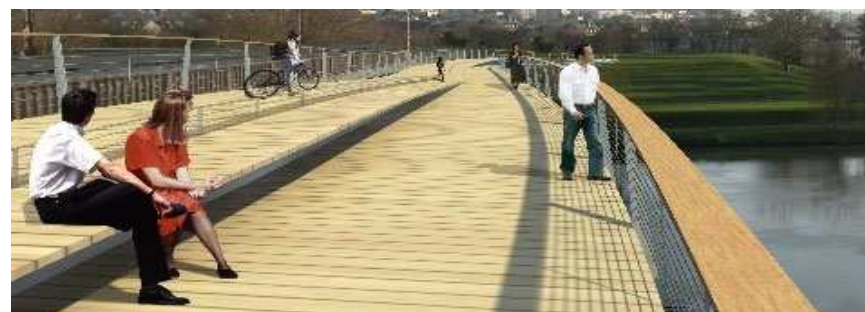
Passerelle piétons et cycles Mantes – Dietmar Feichtinger, Architecte - Ingénieur- Limay © Seine Aval
