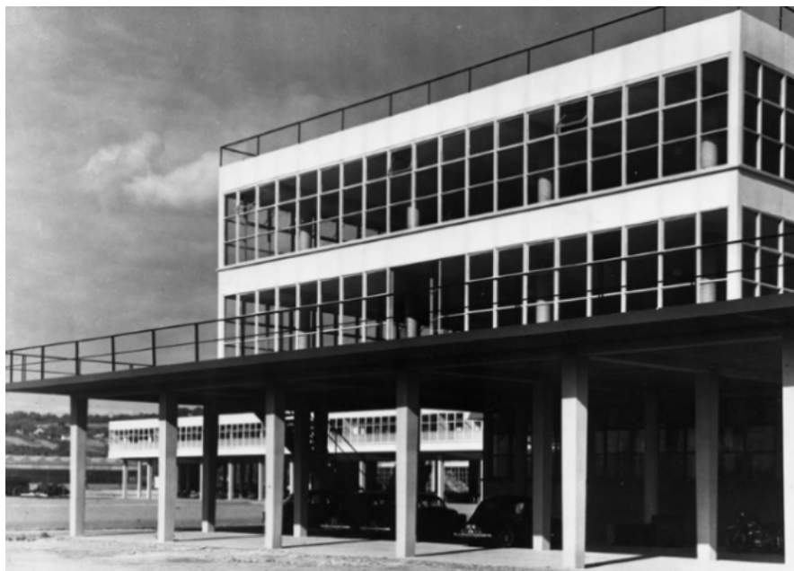
Vestiaire et réfectoires de l'usine Renault par l'architecte Bernard Zehrfuss à Flins-sur-Seine - © Renault Communication - DR
