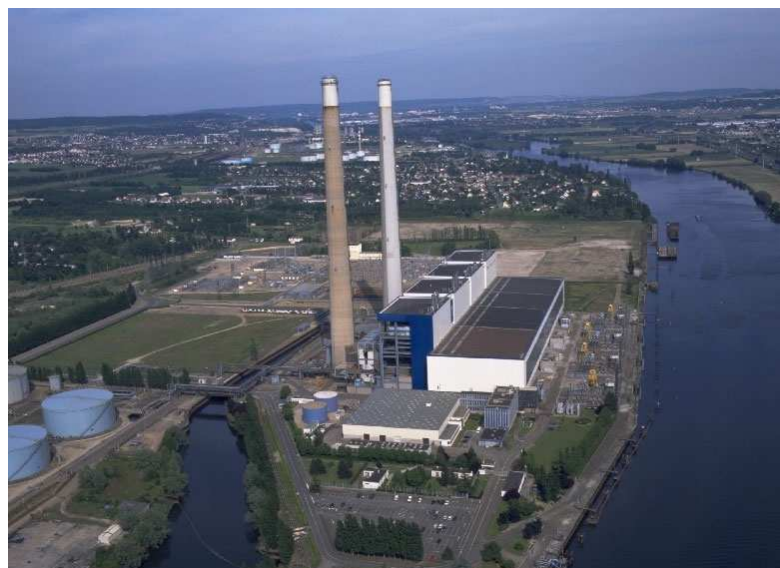
La Centrale de Porcheville dans son Site industriel de Limay - Porcheville
