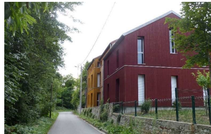
Réalisation de 10 logements sociaux et réhabilitation d'une maison de maître à Follainville-Dennemont
