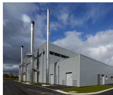
Chaufferie Bois – Mantes-la-Jolie
