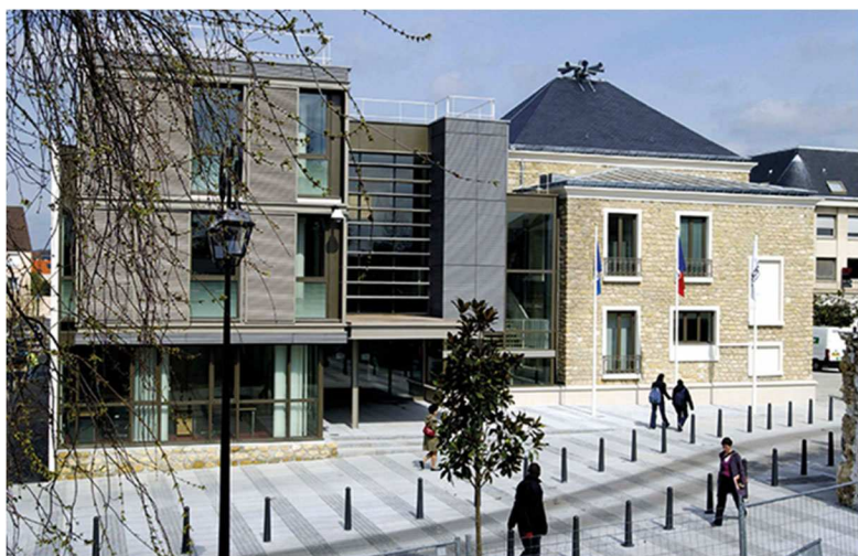
Circulation apaisée en centre-ville des Mureaux
