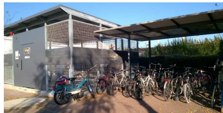
Stationnement à vélo sécurisé et stationnement à vélo abrité en gare de Vernouillet-Verneuil
