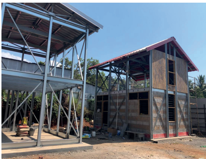
Travaux de recherche Source et crédit photographique : Harapa, EPFAM, DEAL Mayotte
