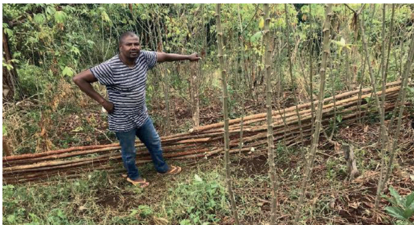
Exemple de fascines Source et crédit photographique : BRGM
