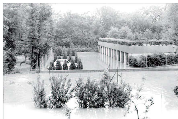
Figure 15 : Inondations devant la gare de Bièvres (source : Association « Les amis de la Bièvre »)
