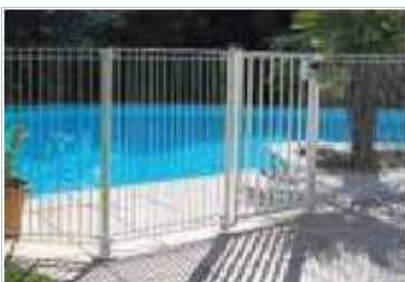
Figure 7 : Barrière de protection ajourée
