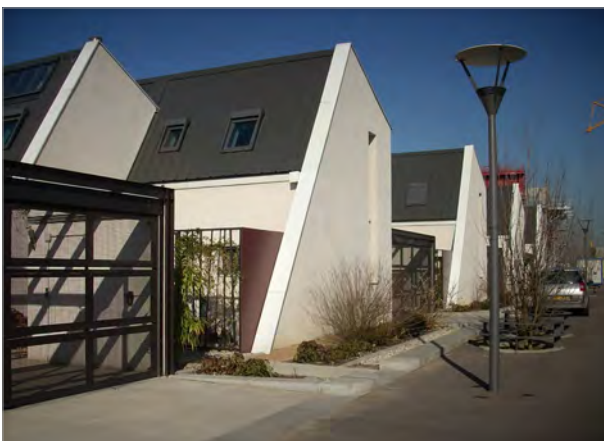
Logements de Haute Qualité Environnementale Hauts-de-Feuilly - Saint-Priest
