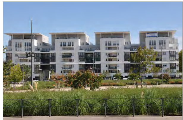
Logements collectifs - Lyon 7 e
