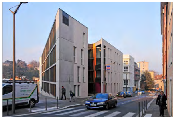
Immeuble de bureaux - Oullins
