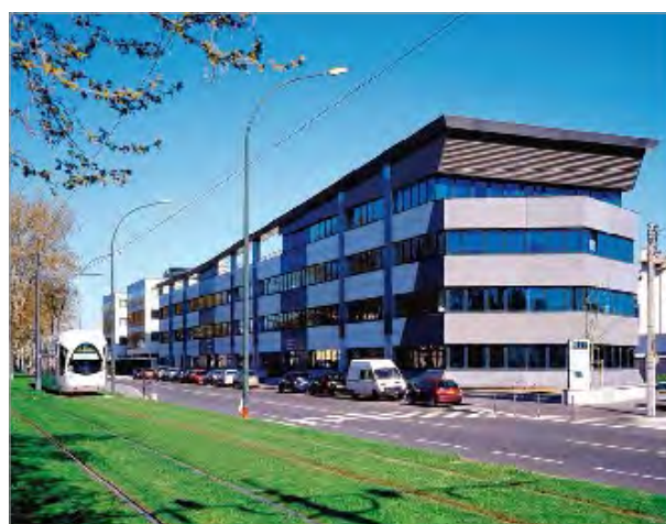
Einstein, pépinière d'entreprises - campus LyonTech-La Doua - Villeurbanne
