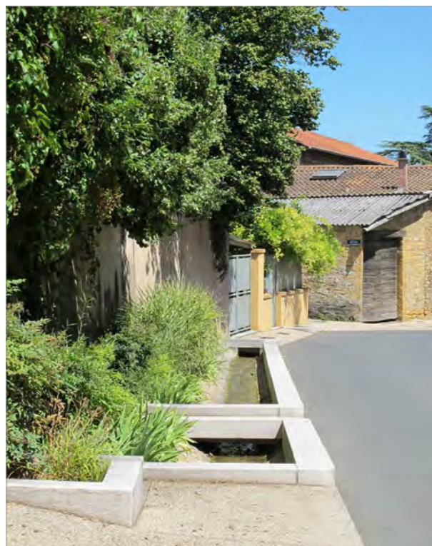
Aménagement paysager pour la gestion des eaux - Saint-Romain-au-Mont-d'Or
