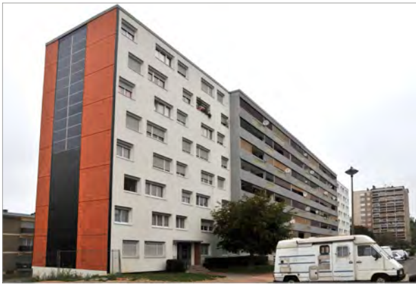
Immeuble réhabilité - Rillieux-la-Pape
