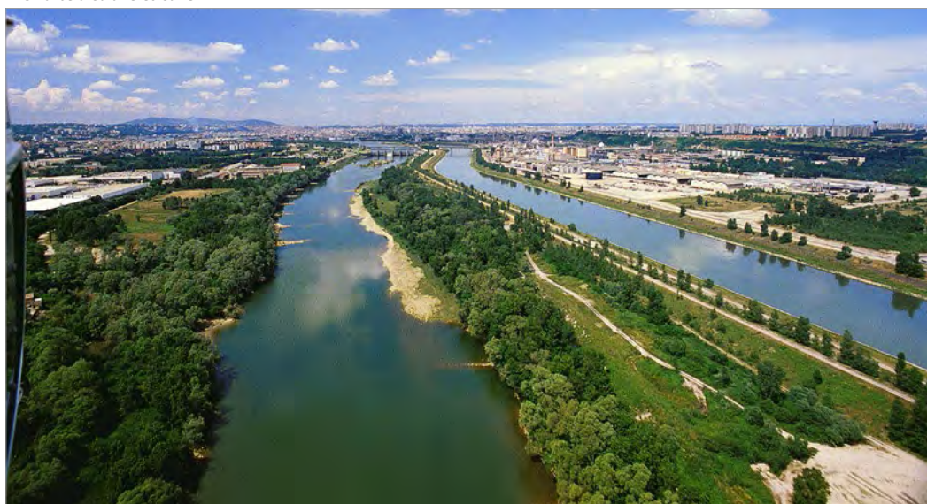
Canal sud du Rhône
