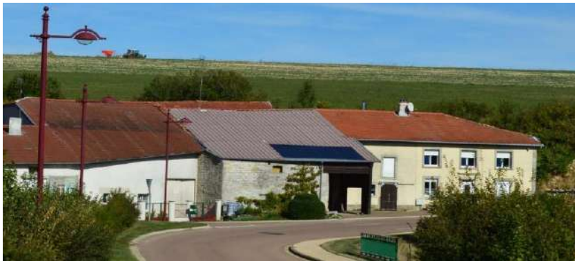
Dispositif de production d'énergie solaire installé sur un bâtiment de stockage agricole le long de la RD960 sur la commune de Sauron – (source : CCBJC)
