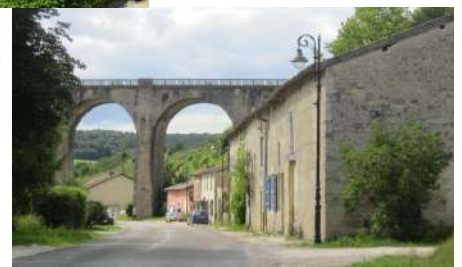
Viaduc de Thonnance-les-Moulins (source : CCBJC)
