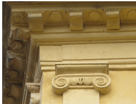
Pilastre, chapiteau corniche à modillons
