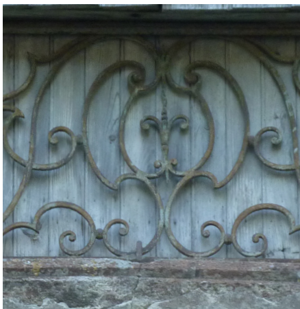
Garde corps de balcon, ferronnerie, fers carrés et dessin de type XVIII e siècle.
