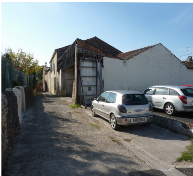
Fig.1 . Démolitions et dents creuses, insertion des parcs de stationnement dans le tissu urbain
