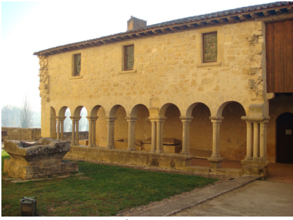
Vestiges du prieuré Saint-Sauveur.
