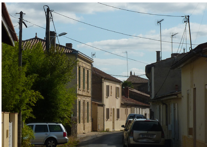
Fig. 4. Antennes et réseaux électriques
