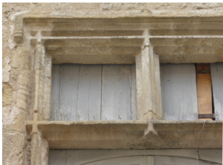
Encadrement de fenêtre «Renaissance» avec corniche et réseau de baguettes.
