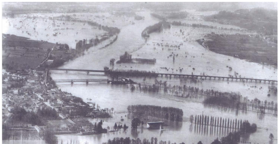
7 - La crue de 1930 : un viaduc perméable à l'inondation qui permet le maintien du trafic ferroviaire
