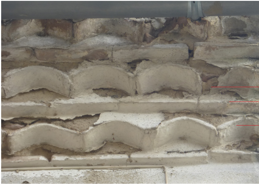
Génoise à plusieurs rangs de tuiles
