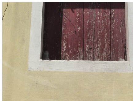
Enduit à la chaux et badigeon ocre, l'encadrement de la baie est dessiné au badigeon blanc.
