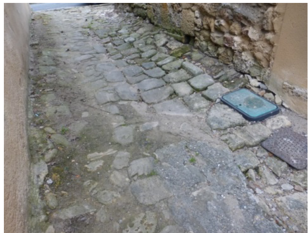
Sols urbains anciens rendus étanches avec un jointolement au ciment.
