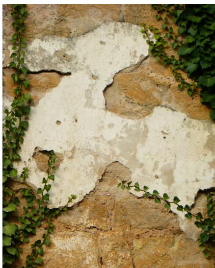
A gauche : vestige d'enduit ancien à la chaux et aux sables locaux et badigeon. A droite enduit et badigeon. L'encadrement de la baie a été redessiné au badigeon blanc.
