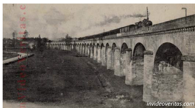
3 - Le viaduc du chemin de fer, hors d'eau
