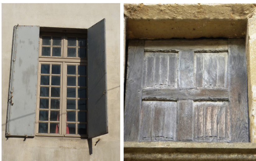
Menuiseries de contrevents, fenêtres et volets à forte valeur patrimoniale. Ils sont à entretenir, restaurer, régler ou calfeutrer.
