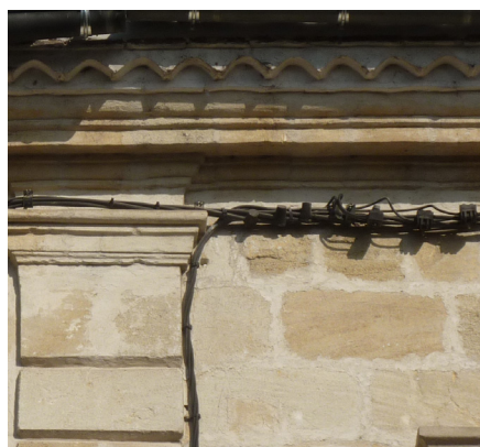
Détail : chaîne d'angle et modénature en pierre de taille, façade en pierre de taille apparente.
