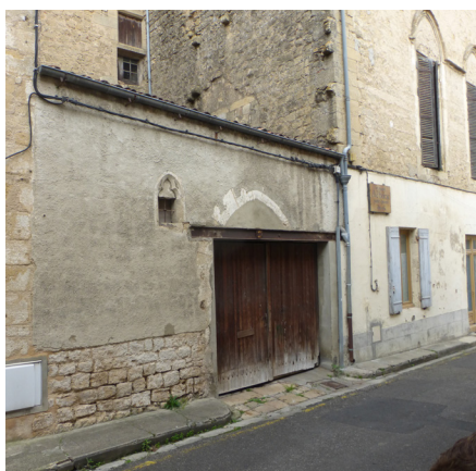
Ancien transformé, problématique de la restitution et de la valorisation des témoins archéologiques ( arcature et baie trilobée).
