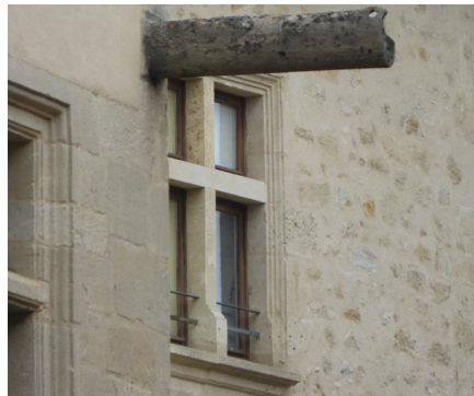
Enduit à pierre vue à la chaux
