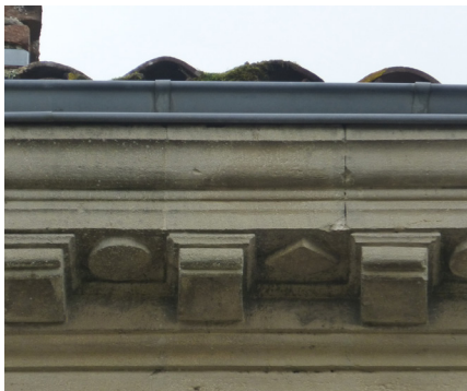
Corniche en pierre de taille
