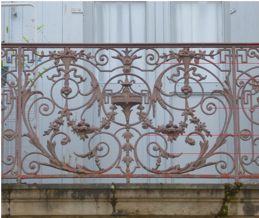
Garde corps de balcon, ferronnerie à motif de rinceaux, XIX e siècle, fer forgé et fonte
