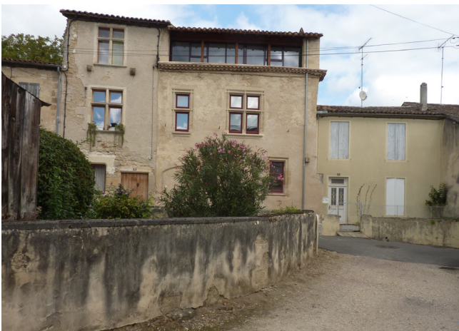
Exposition favorable pour cette façade dont les larges croisées ouvrent sur une cour jardinée. La façade a été rehaussée pour accueillir une soulane permettant de bénéficier au mieux des apports solaires.
