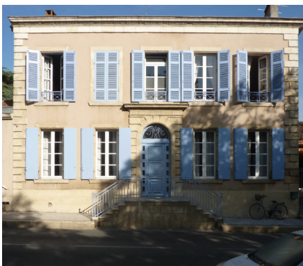
Encadrements et modénature en pierre de taille, maçonnerie de moellons enduite à la chaux.
