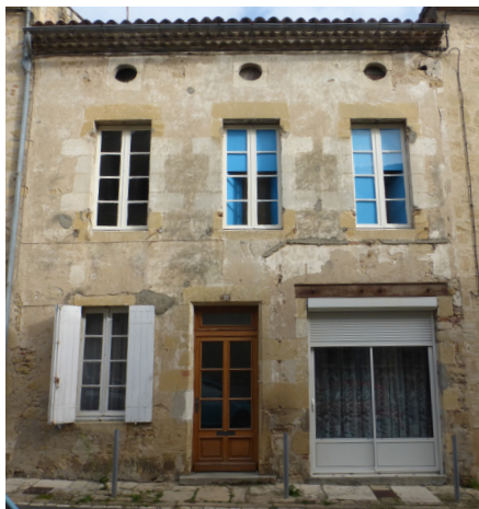
Menuiseries PVC, coffre de volet roulant en applique sur la devanture
