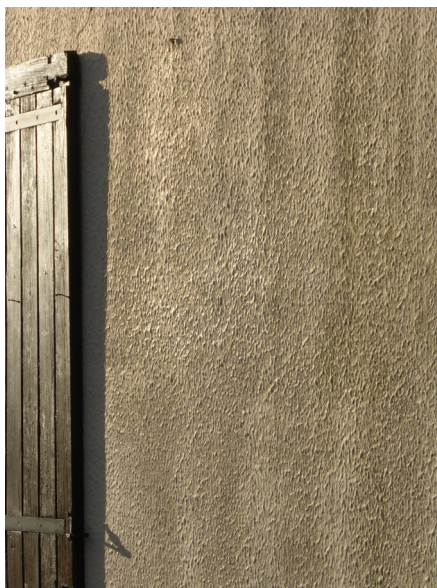
Enduit plastifié en façade
