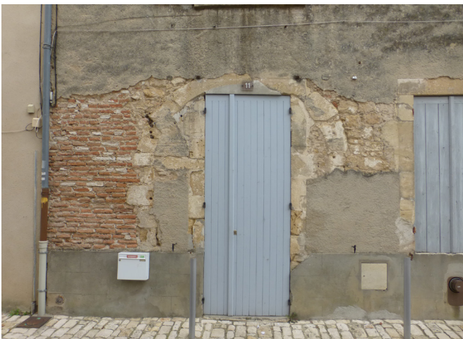
Étanchéité des bas de murs et des sols urbains, conséquences sur la santé des murs anciens.
