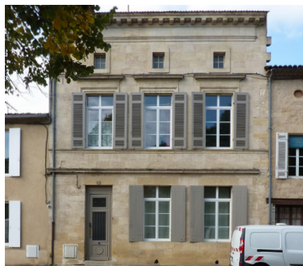
Parement de pierre de taille sur l'ensemble de la façade.
