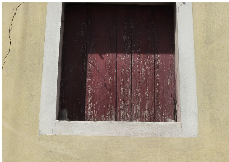
A gauche : vestige d'enduit ancien à la chaux et aux sables locaux et badigeon. A droite enduit et badigeon. L'encadrement de la baie a été redessiné au badigeon blanc.
